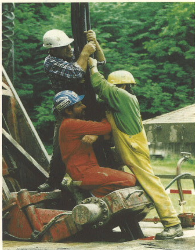
Construction d'une sonde géothermique: implantation de circuits de tubes en U dans le forage (Source: Foralith AG, Gossau)
