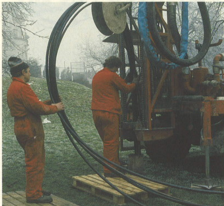
Forage pour sonde géothermique: la longueur des sondes utilisées actuellement varie entre 50 et 250 m
