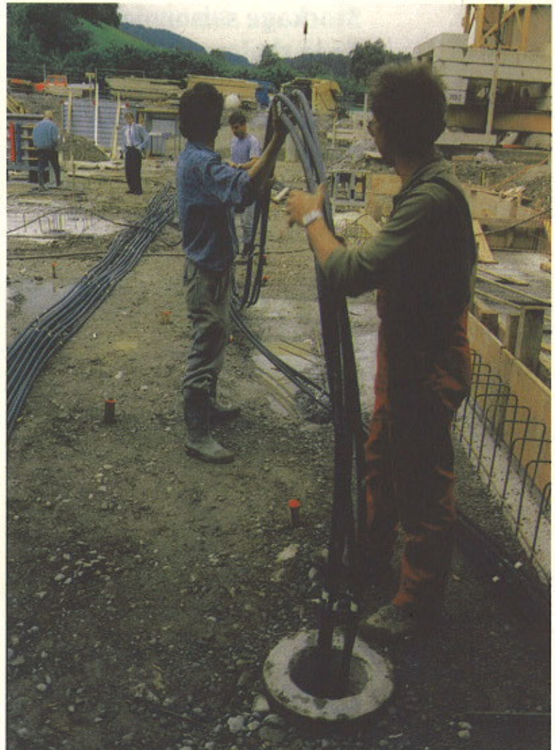
Implantation du circuit de tubes en U dans un pieu évidé battu, en béton centrifuge (Source: Sacac Schleuderbetonwerk AG, Lenzburg)
