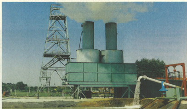
Test de production de l'installation-pilote Hot Dry Rock à Soultz-sous-Forêts (Alsace) en été 1995: production de vapeur avec une température excédant 140°C (Source: SOCOMINE, France)
