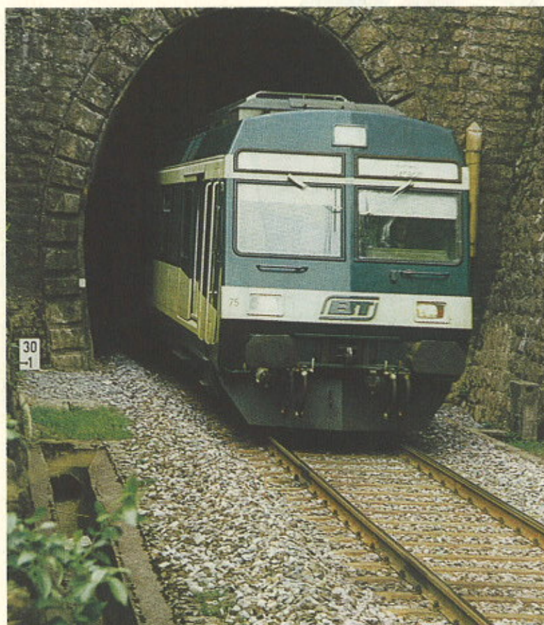
Exploitation de l'eau chaude des tunnels: à la sortie du tunnel du Ricken, l'eau de drainage est collectée dans une rigole, visible en bas à gauche, aux fins de chauffage de la salle polyvalente de Kaltbrunn
