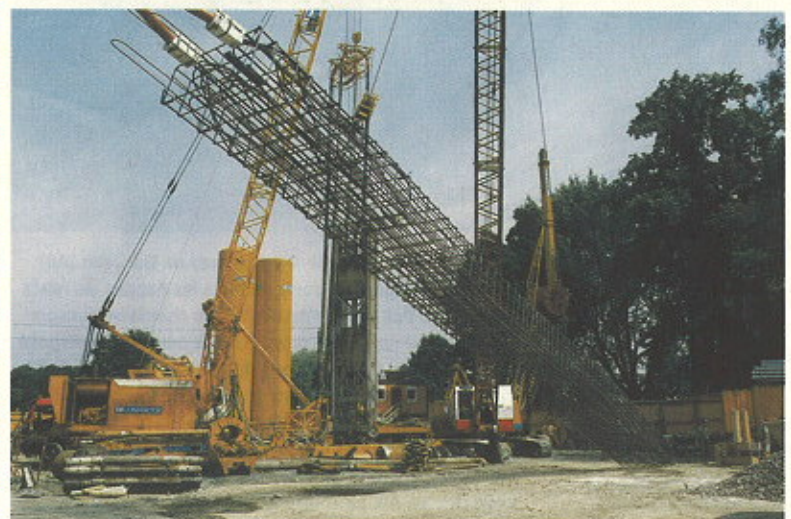
Montage d'une cage d'armature contenant les conduites nécessaires à un échangeur thermique pour une paroi moulée dans le sol (Source: Photo Nägelebau, A-Röthis)
