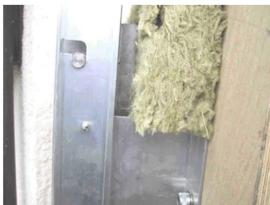
Bilder 5.2 und 5.3: Prinzip der Aufhängung: Die Führungsnut ist hier direkt in das Profil der Unterkonstruktion gefräst. Die definitive Lösung sieht eine separate Montageschине vor, um das UK-Profil nicht zu schwächen.
