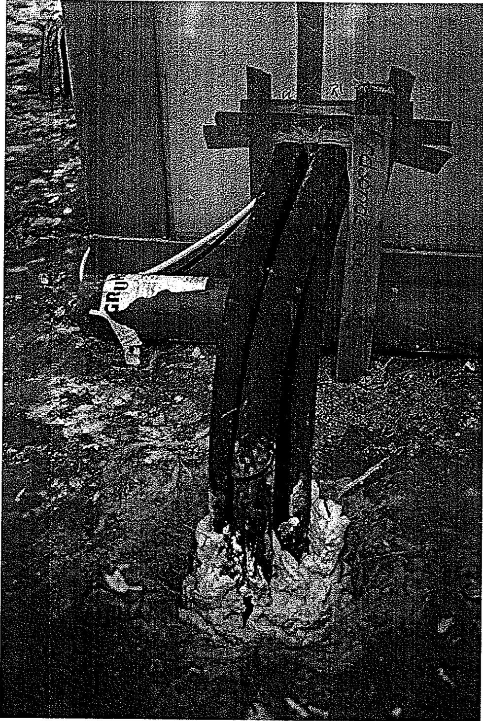
Tuyaux reliant la sonde géothermique Est au local tempéré. Un bouchon de mousse isolante a été injecté dans les 20 premiers centimètres du forage.
