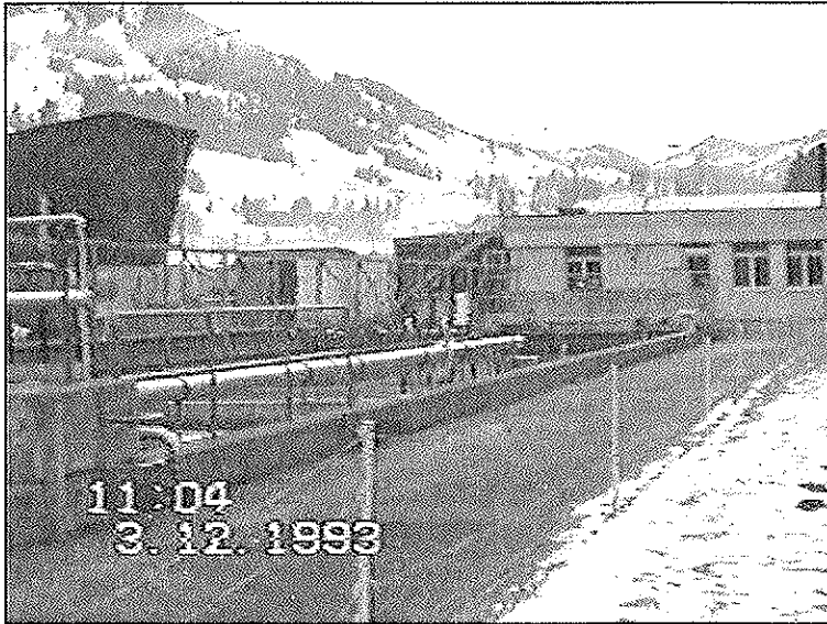
Blick über die Becken der ARA Frutigen zum Betriebsgebäude und Vorfaulraum (im Zentrum neben dem Betriebsgebäude)
