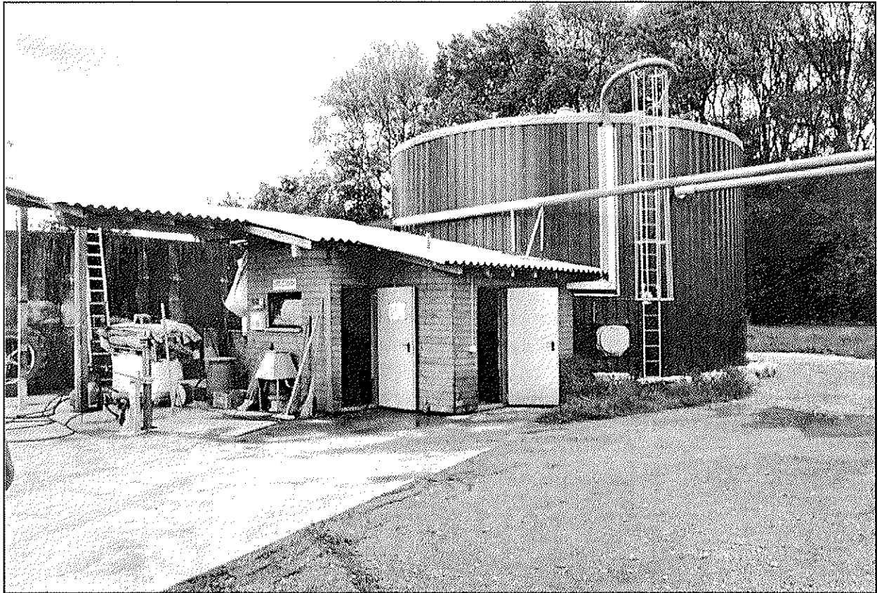
Ansicht des Fermenters und des Betriebsgebäudes der Anlage Günthardt, Dällikon. Links vor dem Gebäude ist die Vorgrube, wo die externen Abfälle eingespeist und durchmischt werden.
