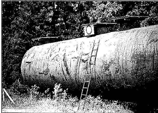
Gasspeicher aus Occasionsmaterialien, Süderen
