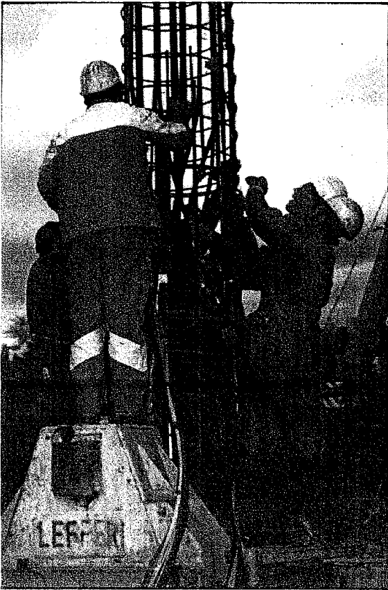
Photo 8 : Pose cage d'armature
