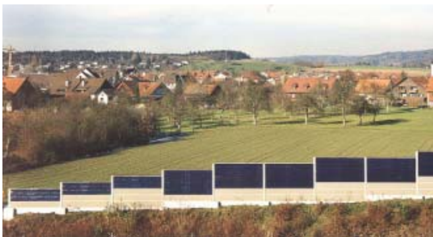
Bild3, 10 kWp Leistung aus flexiblen amorphen (triple junction) Modulen auf konventionellen Alu-Lärmschutzkassetten.
