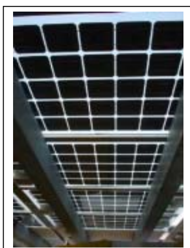
Photo 4 Couverture étanche de la cage d'escalier effectuée avec des panneaux translucides
