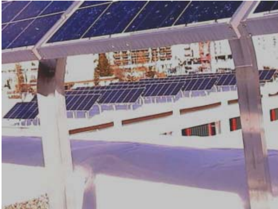
Bild 5: Weiterentwicklung "Davoser Sonne" mit 0.9m Bodenfreiheit
