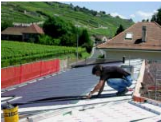
Bild 3: Montage der PV Dachintegration mit amorphen Tripelzellen 'Freestyle®' in Lutry, (Bildquelle: Solstis)
