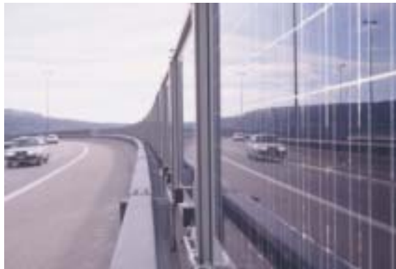
Bild1, Nord-Süd verlaufende Bifacial PV-Schallschutz Anlage
