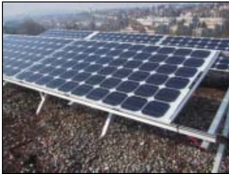
Abb. 3: Standard Unterkonstruktion mit horizontalem Modul-Befestigungsprofil
