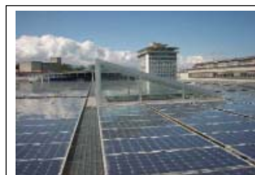
Photo 3 Cet observatoire entièrement vitré permet au visiteur d'avoir une vue sur le champ de capteurs. L'observatoire occasionne des ombrages et provoque une diminution de la production
