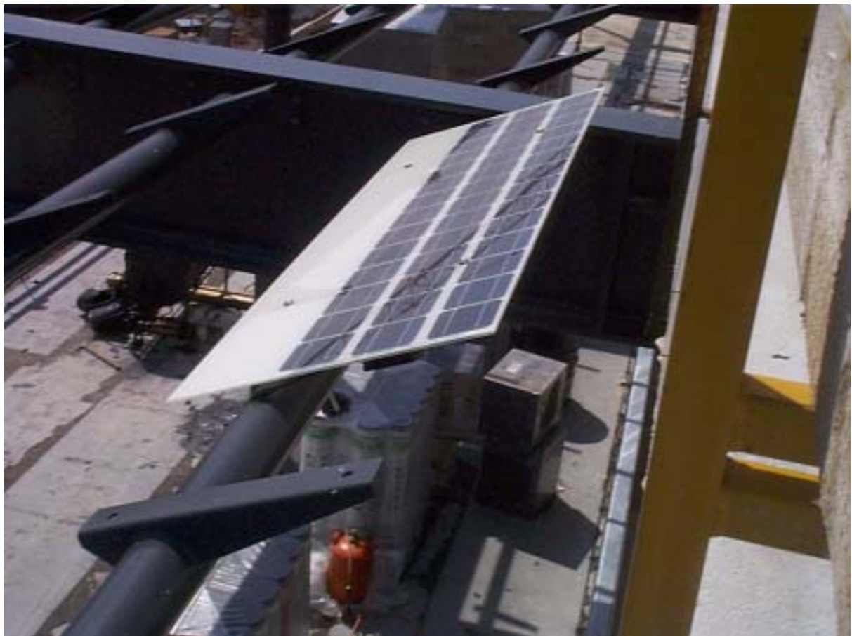
Bild 1: Detail Modulmontage. Der untere Teil des Moduls wird von der nächsten Reihe beschattet.
