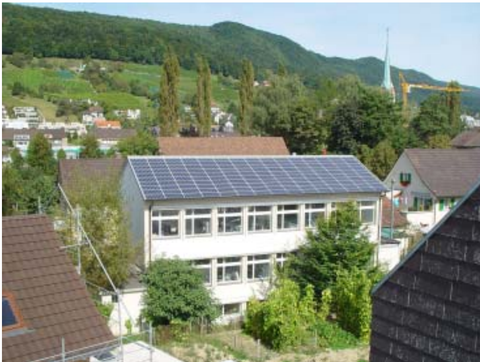
Das Ziegeldach wurde vollständig ersetzt durch Module, deren neuzeitliche Materialfarben bewusst gezeigt und auch in den First- und Randabschlüssen aufgenommen werden.
