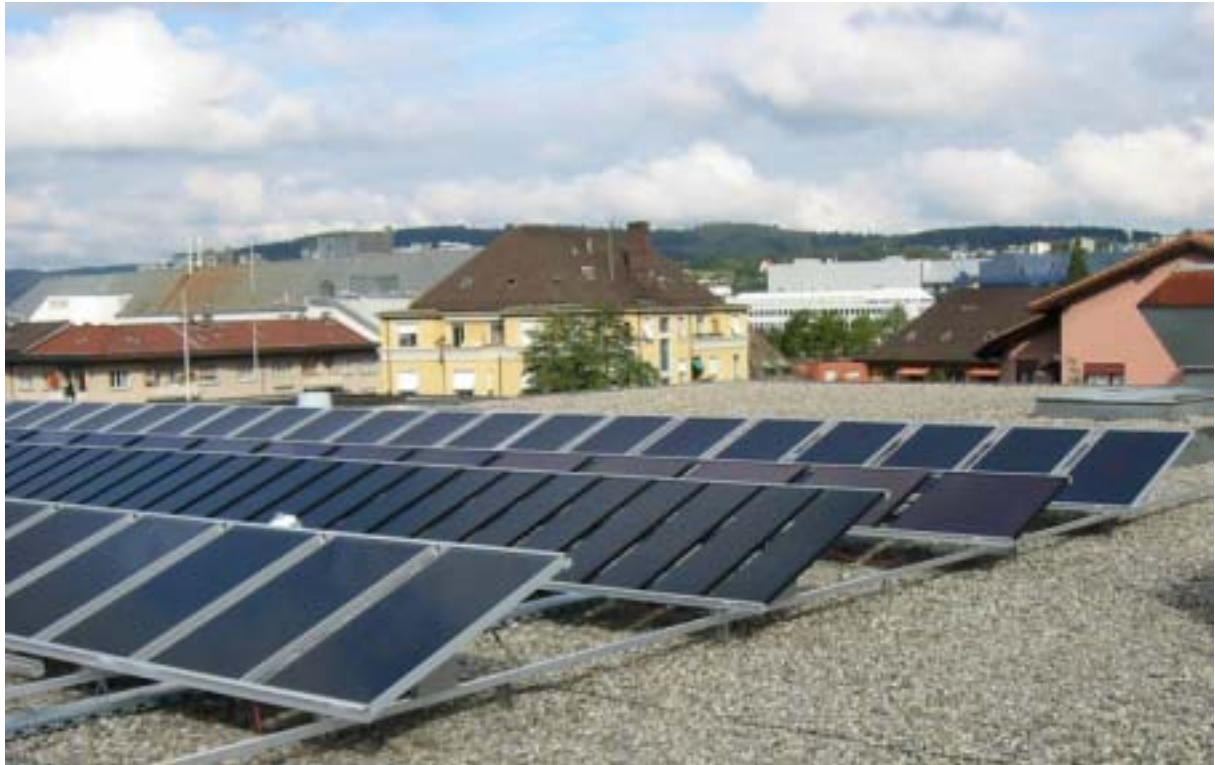
Foto 6. Teilansicht Dünnschicht-Test-Solarstromanlage. Modultypen von vorne nach hinten: BP850, ST40, K58 und US-64.
