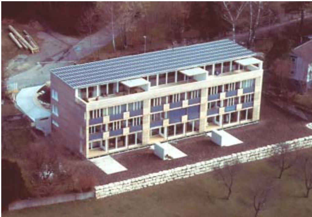
Bild 1 Flugaufnahme von Sunny Woods, leicht gegen Süden geneigtes Pultdach, vollflächig als Eurodach ausgeführt und mit 504 UNI-Solar Modulen US-32 belegt, keine Beschattung.
