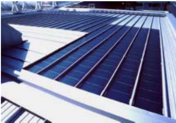
Bild 11: 3 kWp PV Eurodach amorph Flums (Bildquelle: NET AG)
