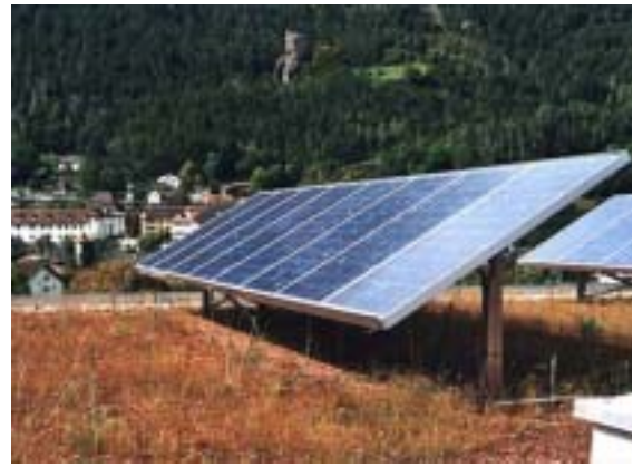
Bild 6: 10 kWp Gründachanlage Solgreen Chur (Bildquelle: NET AG)
