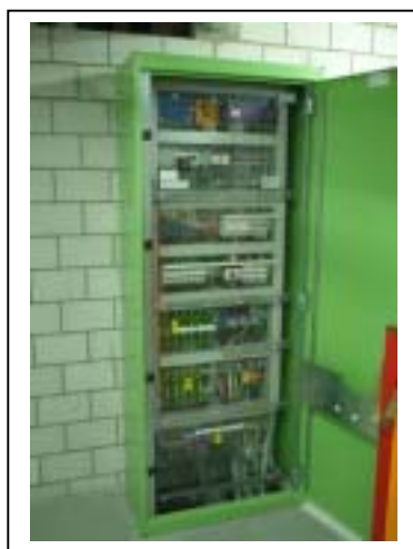
Photo 8 Armoire de disjoncteurs et de monitoring
