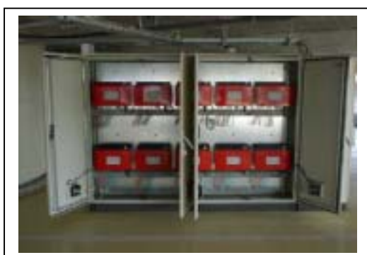
Photo 2 Armoire contenant les 40 onduleurs string, l'ensemble est protégé contre le vandalisme
