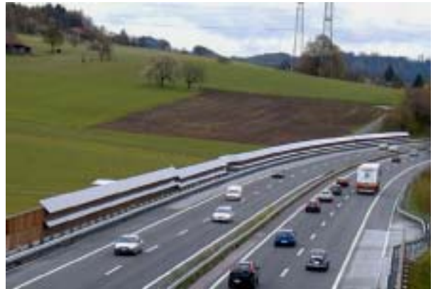
Bild 12: 75 kWp Schallschutz Anlage A1 Safenwil (Bildquelle: BFE )
