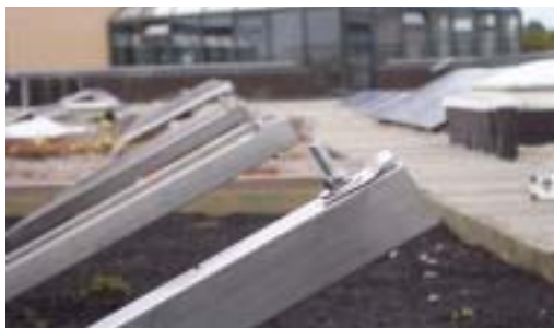
Bild 5: Das Modul kann in die Klammer eingehängt werden.
