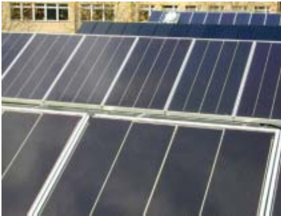
Bild 9: 3x1 kWp Testanlagen Newtech Burgdorf (Bildquelle: NET AG)
