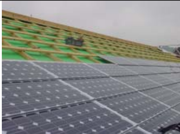
Neue Lattung zur Verbesserung der Hinterlüftung
