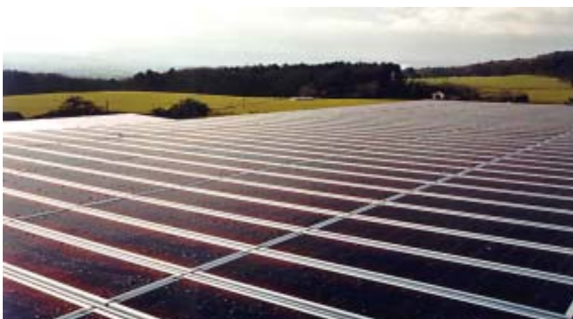
Bild 2 Südausrichtung mit vollflächigem PV Dach (Eurodach)
