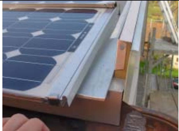
Detail 1 zur Konstruktion der Randabschlüsse
