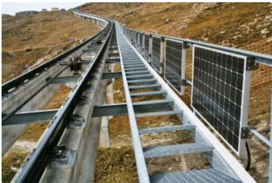
Bild 2: PV Module entlang des Geländers hinter der Sicherheitstreppe
