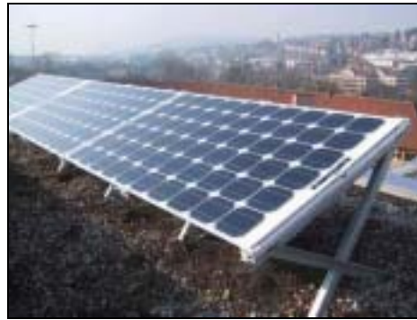
Abb. 4: Modifizierte Unterkonstruktion mit vertikalen Befestigungsprofilen zwecks besserer Hinterlüftung
