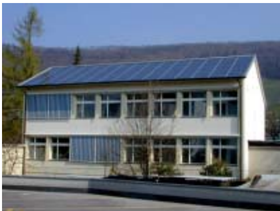
Bild 7: 12,75 kWp Dachintegration Wettingen (Bildquelle: NET AG)
