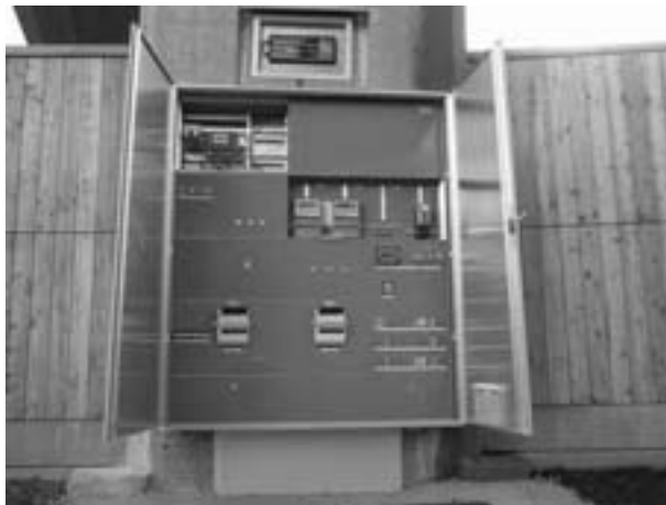
Fig. 4 : Haupt-Schaltschrank mit Leuchtanzeige
