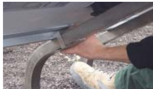
Bild 6: Die Haltebügel werden unten aufgeschoben.
