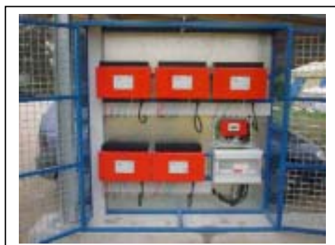
Photo 14 Armoire des onduleurs
