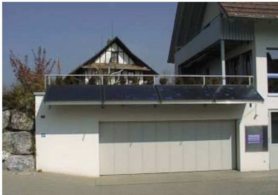
Fig. 1: Anlage Berger installiert als vorgehängte Brüstungselemente
