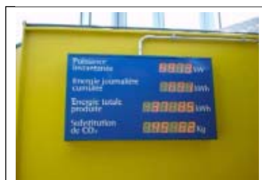
Photo 5 Le panneau d'affichage indique les valeurs instantanées et cumulées de production de l'installation ainsi que le CO 2 qui a pu être évité (comparé à un générateur fioul)
