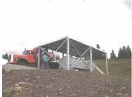
Montage - Vue d'ensemble, angle nord-ouest (13.06.2001)
