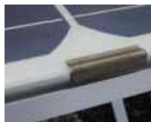
Fig. 13: 13. Aufstecken der Edelstahlhalteklammern als Befestigung der Laminare an den Solface-Profilen
