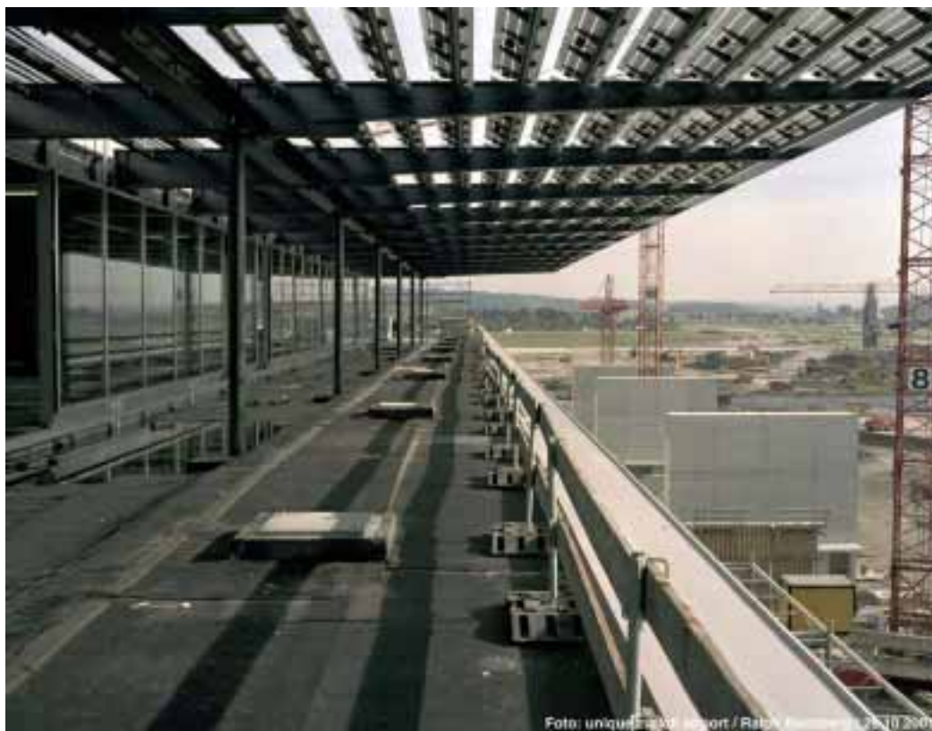
Bild 2: Südliche Terrasse mit der Solarpergola und der beschatteten Lounge-Fassade
