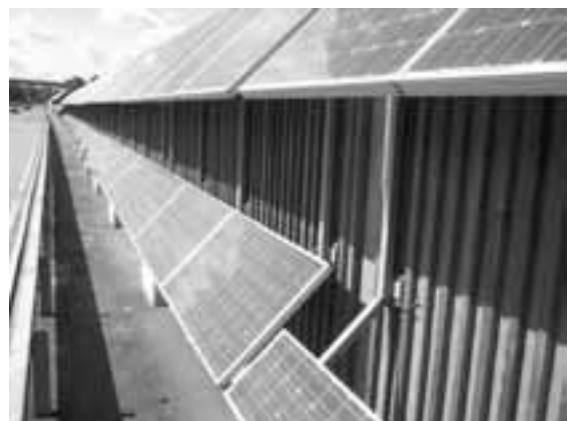
Fig. 8: Einige Wochen später liegt die Schatten-grenze deutlich über der Modulreihe. Aufnahme vom 18. Sept. 2001 um 12.30 Uhr ebenfalls bei ungefähr Sonnen-Höchststand
