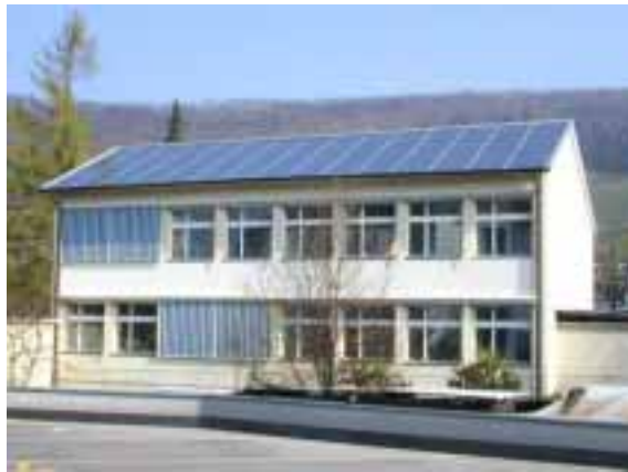
Bild 5: Dachintegration mit SOLRIF Wettingen (Bildquelle: NET AG)
