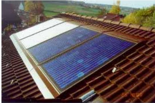
Bild 1: Solar Compactline-PV mit zwei PV-Modulen vertikal
