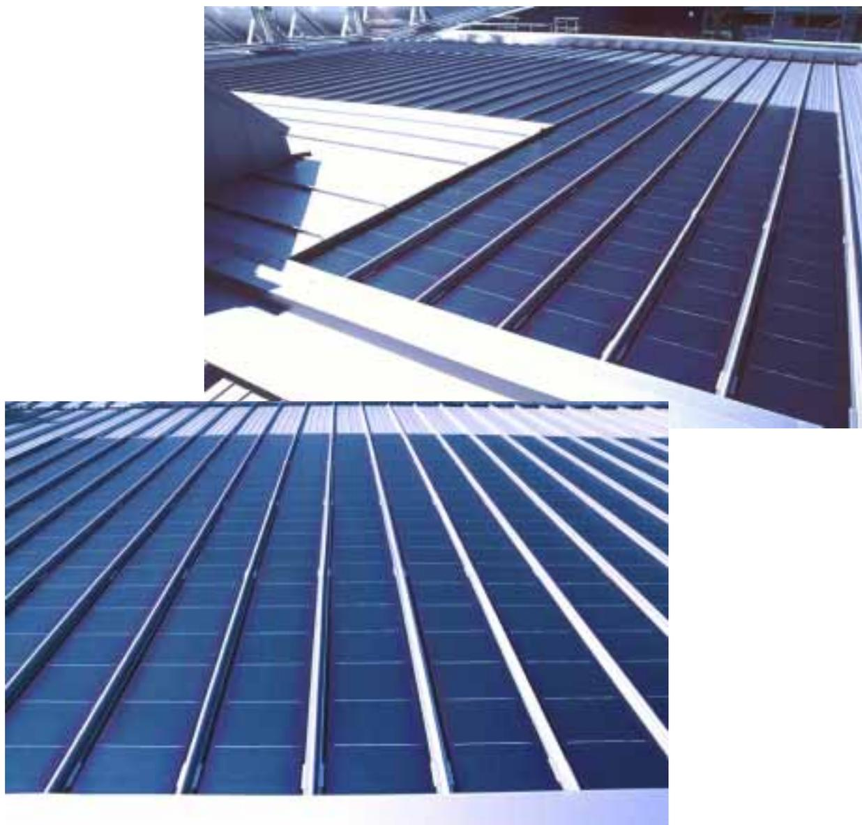
Bild 2: PV Metallfalzdach, thermisch isoliert, Foto: NET AG
