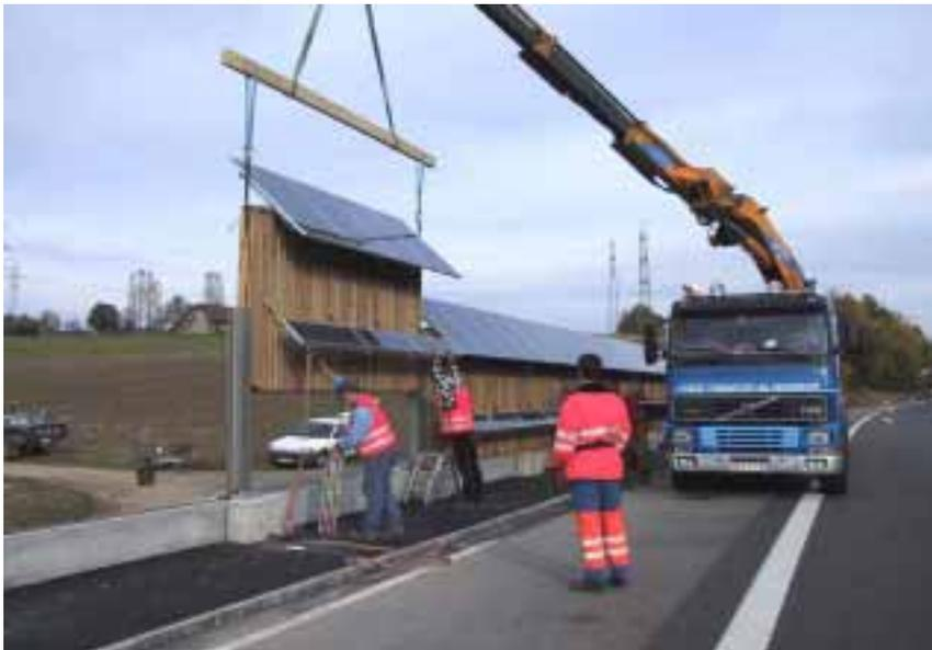
Bild 5: Montage der 80 kWp PV Schallschutzanlage Safenwil
