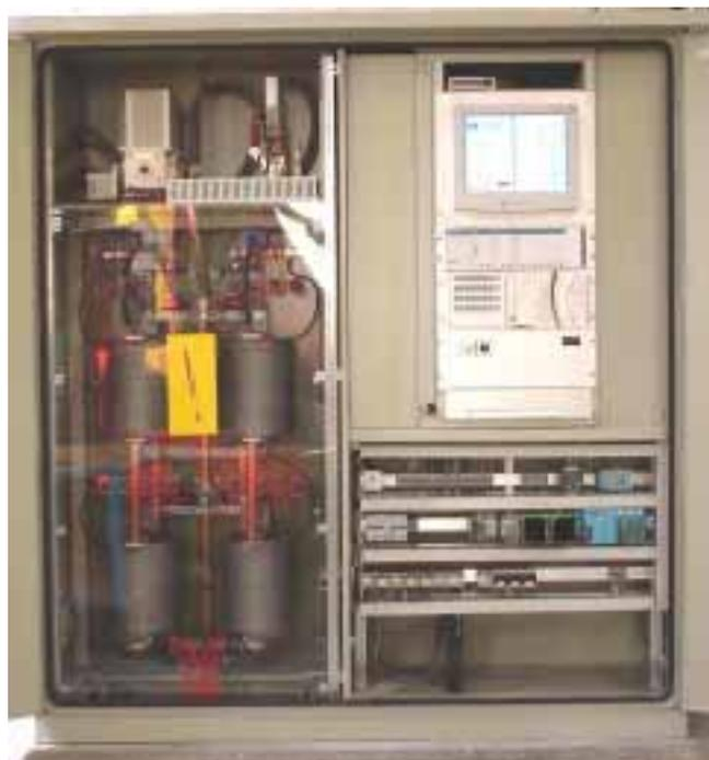
Photo 2: Couplage au réseau DC et système de monitoring
