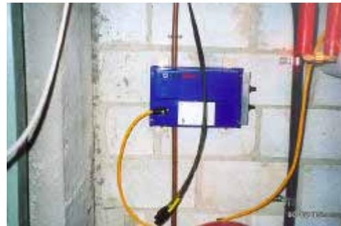
Bild 3: Solcolino mit DC Zuleitung (nicht angeschlossen) und AC-Kabel
