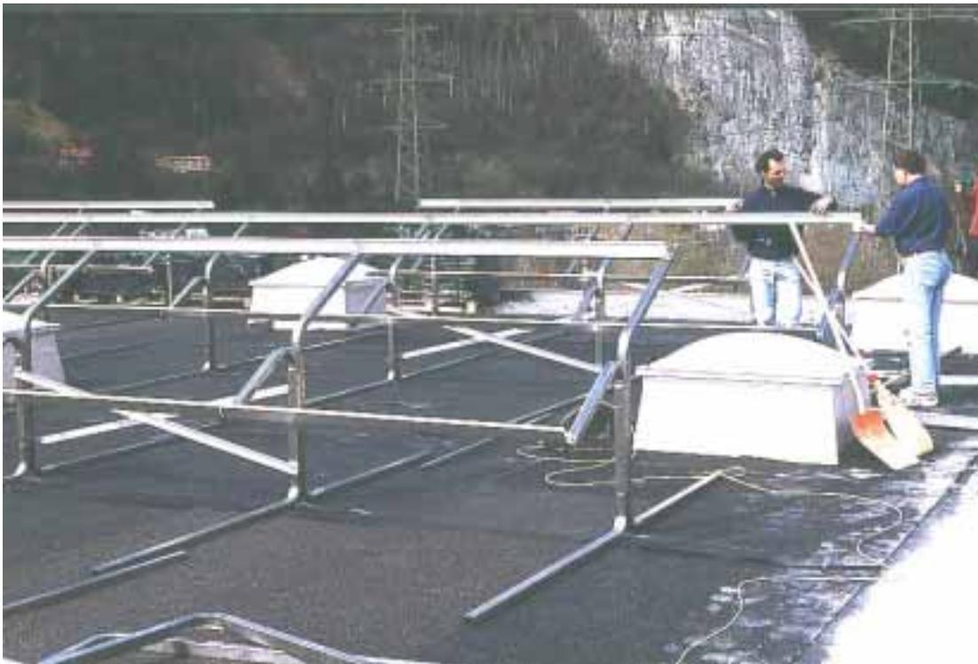
Bild 1: Aufbau der Edelstahl Tragkonstruktion
