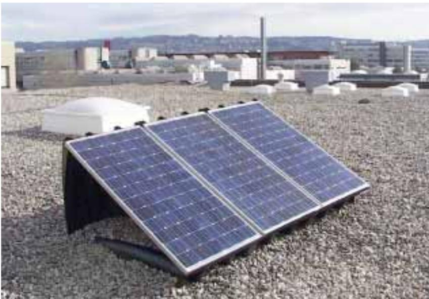
Bild 11: Solmax Unterkonstruktion, Foto: Solstis Sàrl
