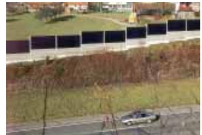
Tab. 1 / Fig. 1: Die Anlage Brüttisellen. Beim Feld mit den Sonderlaminaten wurden die Zellen direkt auf das vordere Deckblech der Schallschutzkassetten laminiert. Es liegt in der Mitte des Gesamtfeldes. Die hier angegebene Nominalleistung der Hauptanlage musste gegenüber dem Werkvertrag reduziert werden. Grund: Die Modulverschaltung reduziert die Leistung mehr als erwartet.
