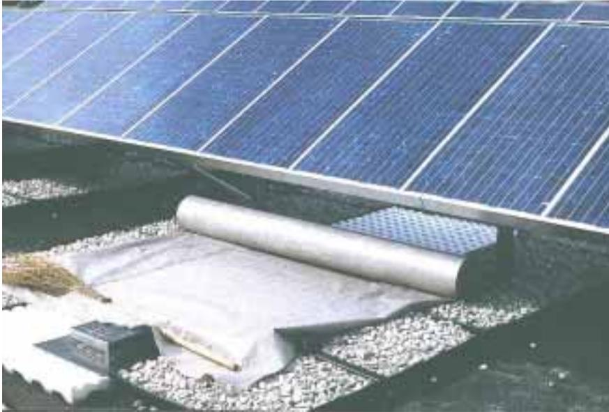
Bild 2: Aufbau des Gründachs, von unten nach oben: Sarnafil-Abdichtung, Gummischrotmatte, Edelstahl-Vierkantrohr der Tragkonstruktion beschwert mit kiesgefüllten SOLGREEN Plaquettes resp. Polystyrol-Platten zum Ausgleichen der Höhe, Trennvlies, Gründachsubstrat (Ziegelschrot aus recycelten Dachziegeln versetzt mit Humus, Pflanzensamen).
