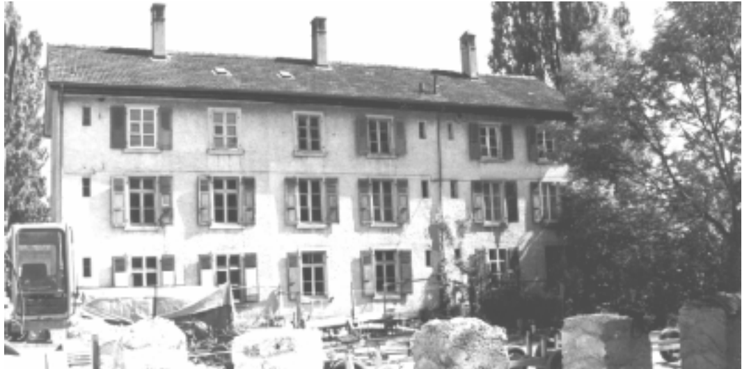
Abbildung 19: Ansicht des Objektes 3 von Norden.
