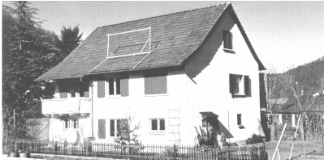
Abbildung 17: Ansicht des Objektes 2 von Süden.
