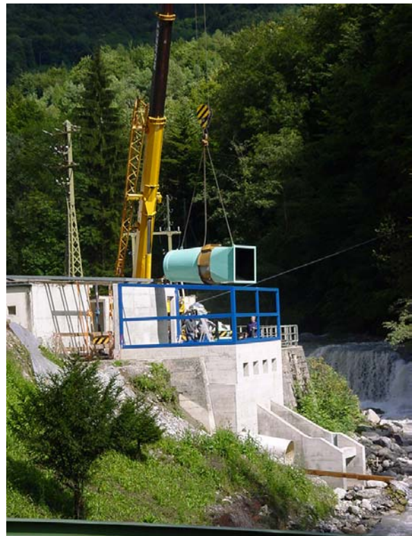
Vue du montage sur site de la turbine des Farettes.
