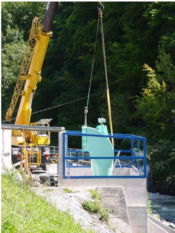
Vue du montage sur site de la turbine des Farettes.
