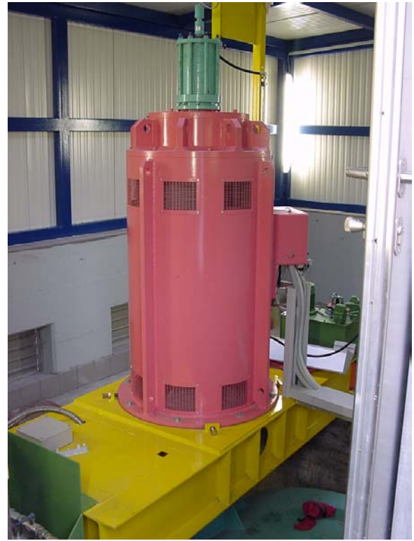
Vue de l'alternateur de la mini-centrale des Farettes
