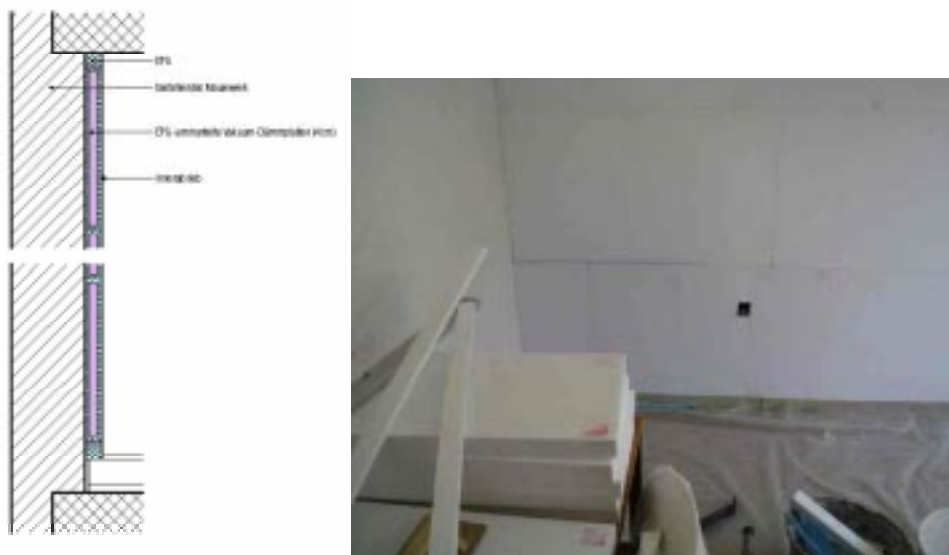
Abb. 19: Innendämmung mit 4 cm starken vacupact-Dämmplatten. Links eine Schnittzeichnung der Konstruktion und rechts ein entsprechend ausgeführtes Beispiel (im Vordergrund ein Stapel der verwendeten Platten).
