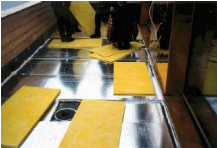
Abb. 17: Ausführung der Dachterrasse mit 5 cm Vakuum-Dämmplatten.
