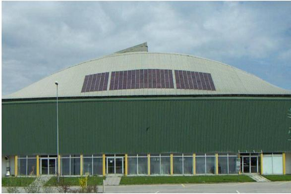
Figure 9 : Toiture Flexcell expérimentale de 2 kW<sub>c</sub> (Source: VHF-Technologies)
