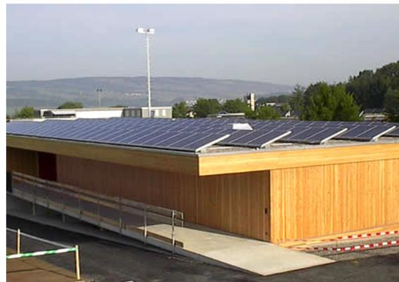
**Figure 5:** Installation AluStand de 27 kW<sub>c</sub> à Hünenberg (Photo: Urs Bühler Energy Systems)
