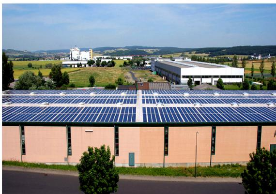
**Figure 4:** Toiture ‚Solar Dach’ de 188 kW<sub>c</sub> à Fulda (Photo: Sarnafil)
