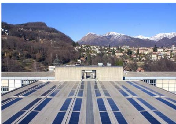
**Figure 8:** L'installation CPT de 15.4 kW<sub>c</sub> intégrée en toiture plate (Photo: NET)
