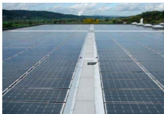
**Figure 11:** Installation de 62 kW<sub>c</sub> avec modules PowerGuard (Photo: Zagsolar)
