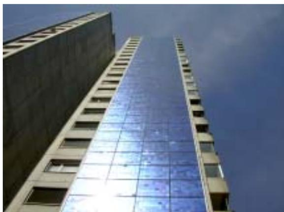
**Figure 18:** Façade de 80 kW<sub>c</sub> à Berne-Wittigkofen (Photo: NET)
