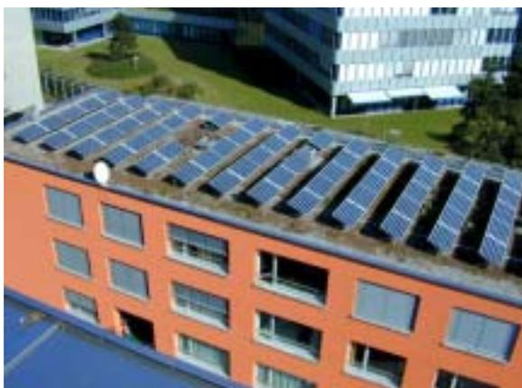
**Figure 17:** Centrale Solgreen 1 intégrée à une toiture-jardin, à Zurich (Photo: NET)
