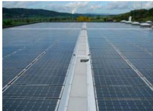
**Figure 14:** Installation de 62 kW<sub>c</sub> avec modules PowerGuard (Photo: Zagsolar)
