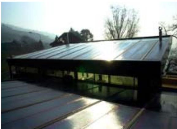
**Figure 21:** Intégration en toiture de 5.5 kW<sub>c</sub>, système Freestyle® (Photo: Solstis)
