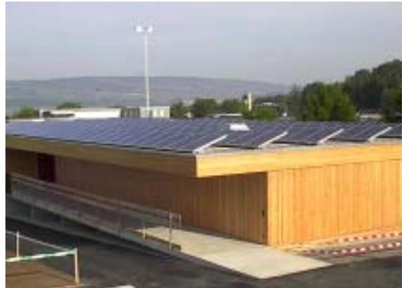
**Figure 16:** Installation AluStand de 27 kW<sub>c</sub> à Hünenberg (Photo: Urs Bühler Energy Systems)
