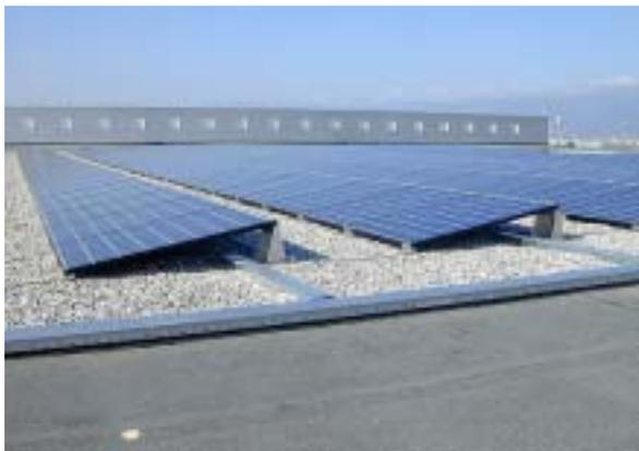
**Figure 25:** Installation de 70 kW<sub>c</sub> sur le toit plat de Palexpo, à Genève (Photo: NET)
