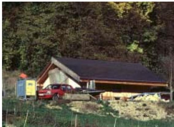
**Figure 26:** Installation PV autonome de 3 kW<sub>c</sub> intégrée en toiture à Soyhières (JU) (Photo: NET)
