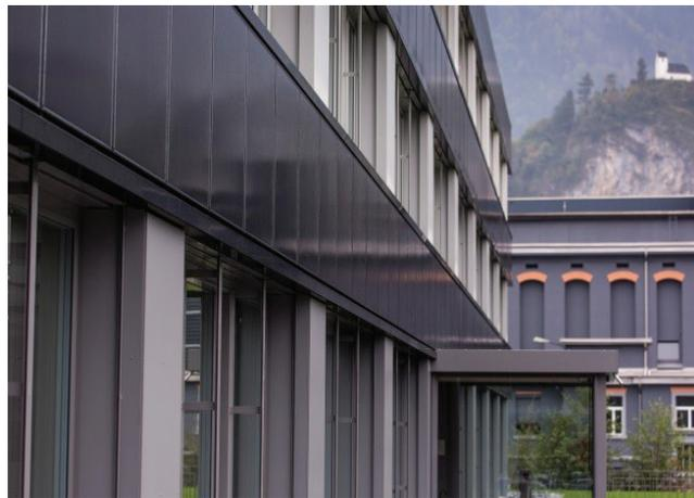
Figur 11: Photovoltaik Fassadenintegration bei Flumroc in Flums (© 2014 Daniel Forster / NET Ltd.)
