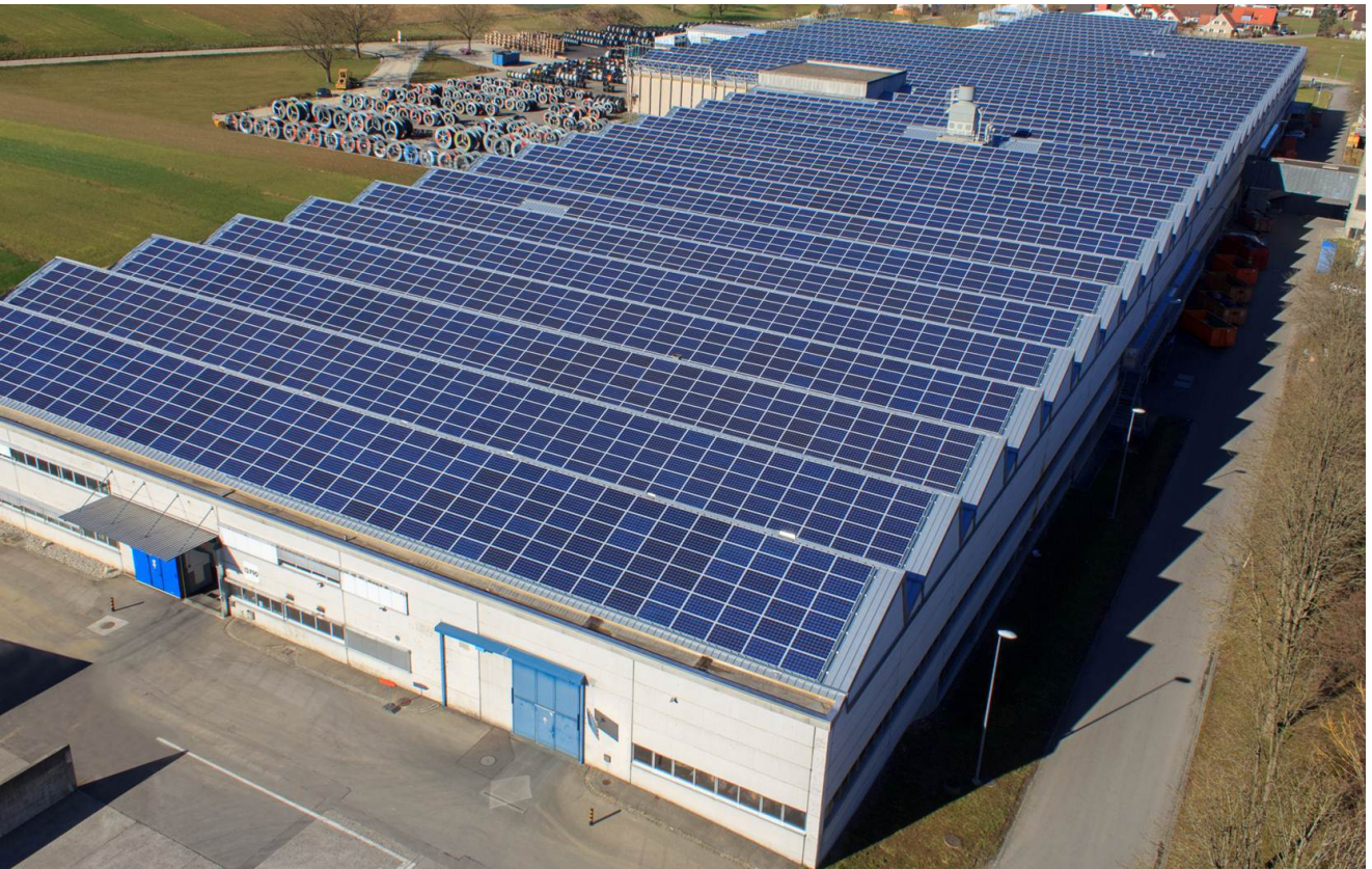
Figur 6: Grosse, leistungsfähige Photovoltaikanlagen, z. B. auf Gebäuden, entsprechen dem aktuellen Stand der Technik und sind immer häufiger anzutreffen. Neue Photovoltaiktechnologien müssen sich an diesen erprobten Konzepten messen können, in Bezug auf Wirkungsgrade, Kosten, Langlebigkeit wie auch die Ästhetik (Aufdachanlage mit Asbestsanierung, 1.928 MWp, Breitenbach (SO), Planung und Realisierung sowie Bildquelle: SOLVATEC AG).
