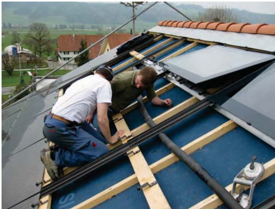
ABBILDUNG 8 EGASLATE II THERMIEPANELE WÄHREND DER MONTAGE
