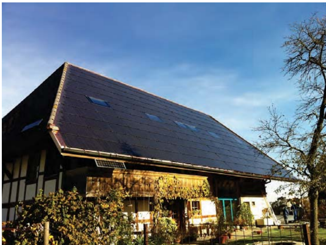
ABBILDUNG 9 ANLAGE MIT INTEGRIERTEN DACHFENSTERN
