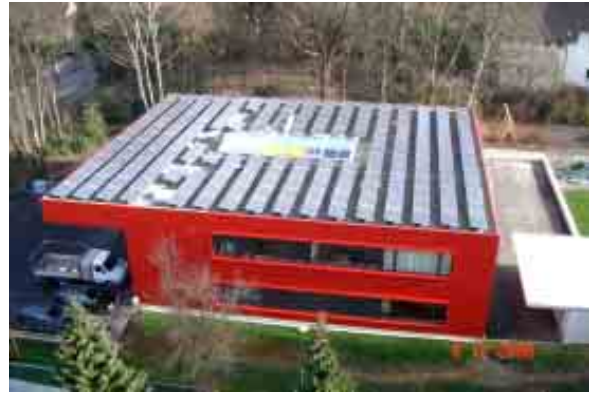
Figur 12: Nullenergieschulhaus Ekkharthof Kreuzlingen (Bildquelle: Böhni Energie und Umwelt)
