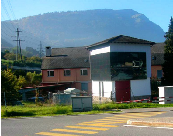
Figur 7 Fassadenintegration mit Dünnschichtmodulen (Bildquelle: Zagsolar)
