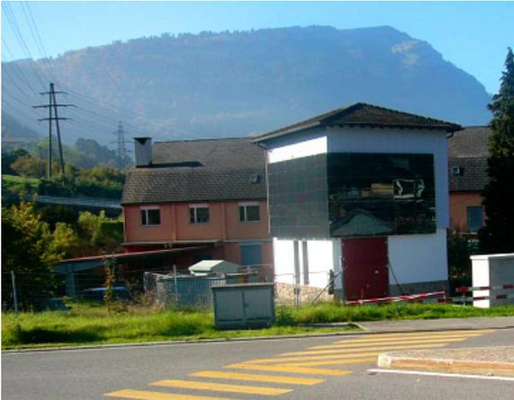
**Figur 7** Fassadenintegration mit Dünnschichtmodulen
