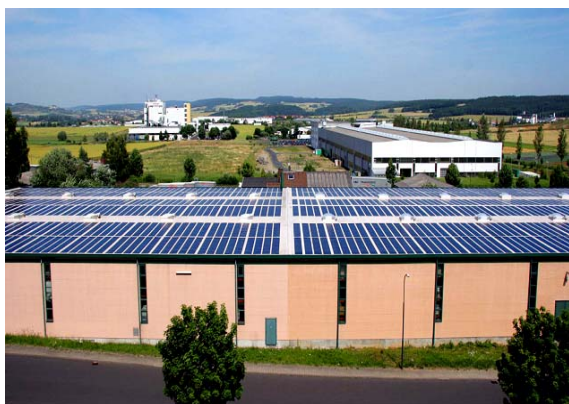
Figur 4: 188 kWp Solar Dach in Fulda (Bildquelle Sarnafil)
