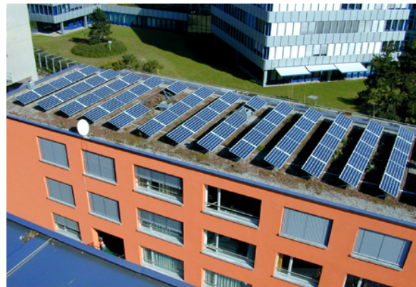
Figur 9: Solgreen Kraftwerk 1 (Bildquelle: NET)
