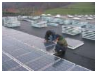
Zusammensetzen der Solardachplatten
