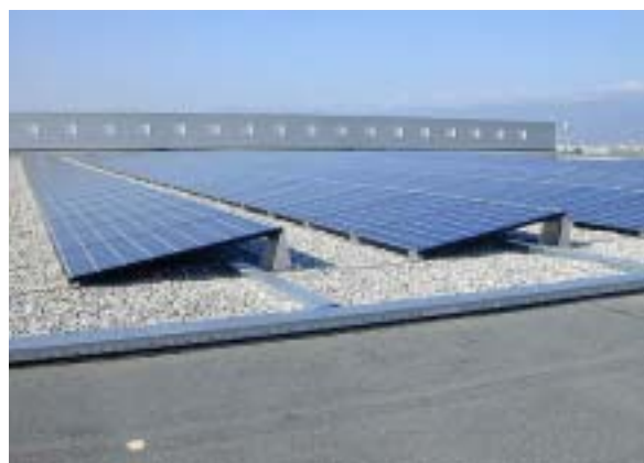
Figur 19: 70 kWp Flachdachanlage Palexpo (Bildquelle NET)
