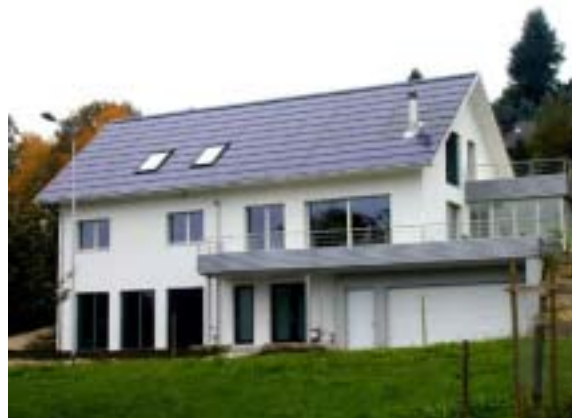
Figur 2: Solarhaus 'Erni' mit SOLRIF Dachintegration (Bildquelle Enecolo)
