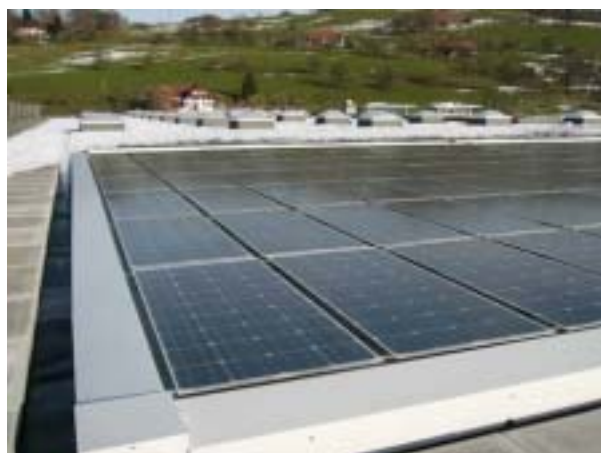
Bild 7: Dachrandabschluss
