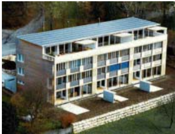
Figur 4: 16 kWp Dachintegration Sunny Woods (Bildquelle Architekturbüro Beat Kämpfen)
