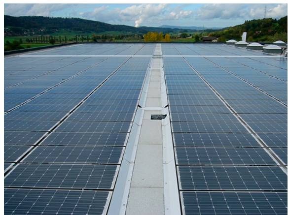
Figur 8: 62 kWp Anlage mit PowerGuard Modulen (Bildquelle: Zagsolar)
