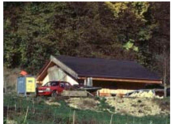
Figur 20: Autonome 3 kWp Dachintegration Soyhières (Bildquelle NET)
