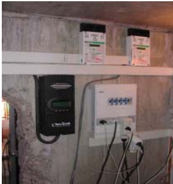
Figure 4 - Solstis a remplacé un des deux régulateurs (en haut) par un MPP tracker (en bas à gauche)
