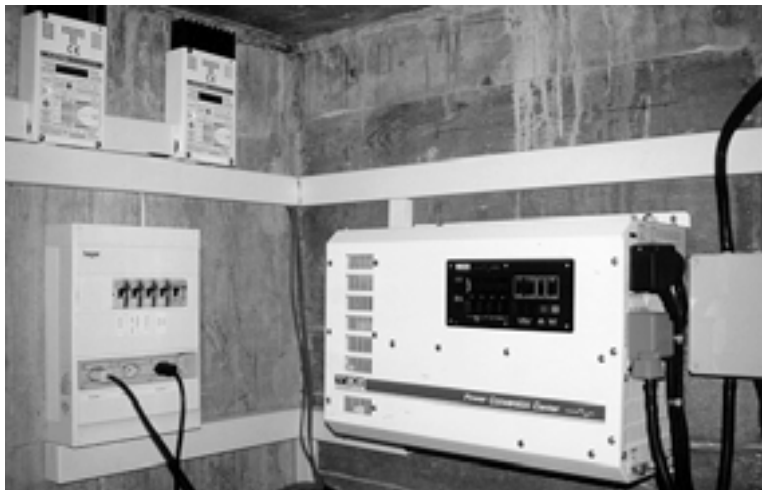
Figure 3 - détail onduleur et tableau électrique
