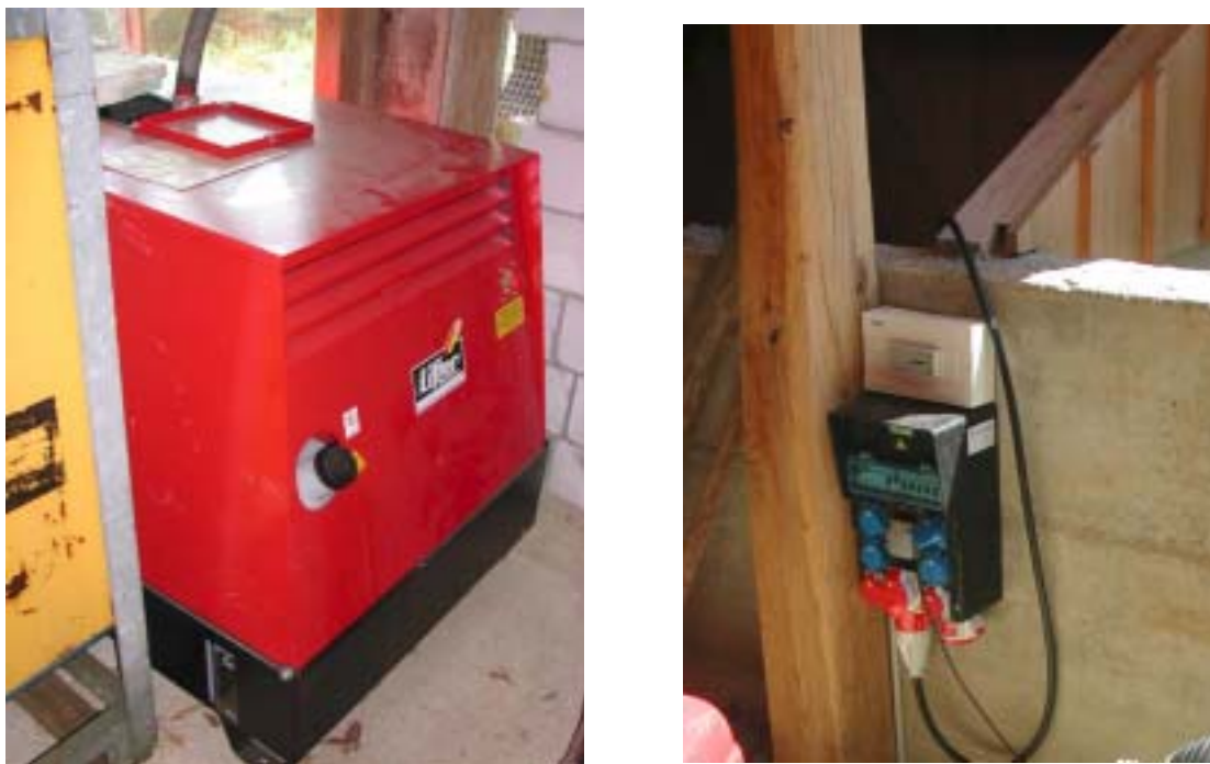
Figure 6 - Le groupe électrogène a été équipé par Solstis d'un compteur d'énergie pour en connaître la production avec précision.
