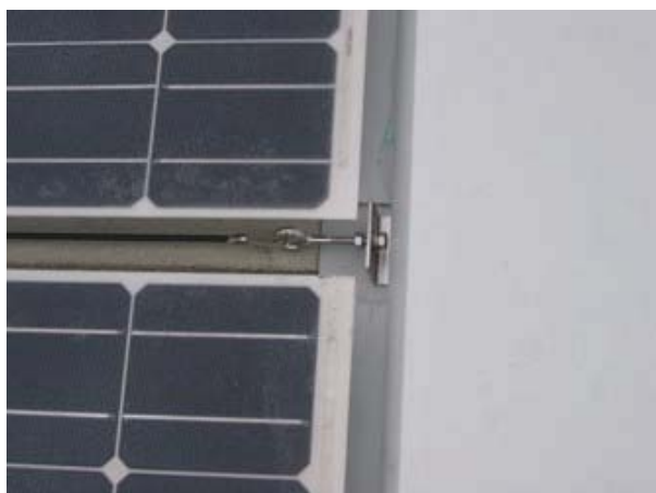
Bild 6: Sicherung mit Drahtseil
