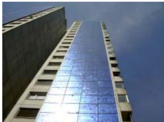
Figur 12: 80 kWp Fassade Bern Wittigkofen (Bildquelle NET)
