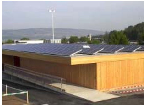
Figur 10: 27 kWp Alustand Hünenberg (Bildquelle Urs Bühler Energy Systems)
