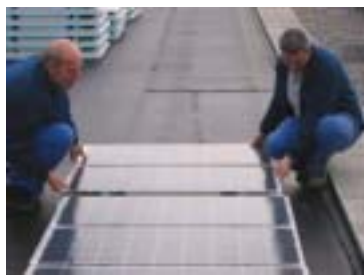
Zusammensetzen der Solardachplatten
