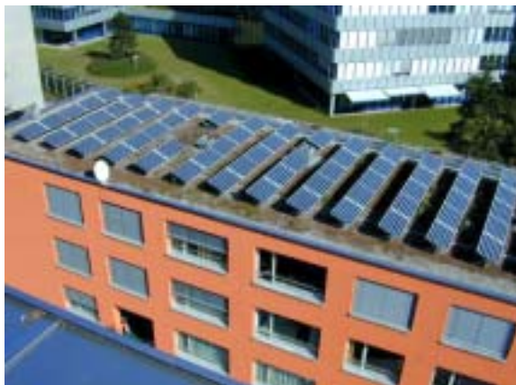
Figur 11: Gründachanlage Solgreen Kraftwerk 1 Zürich (Bildquelle NET)
