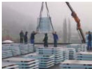
Ablad der Module auf Dach Hochregallager
