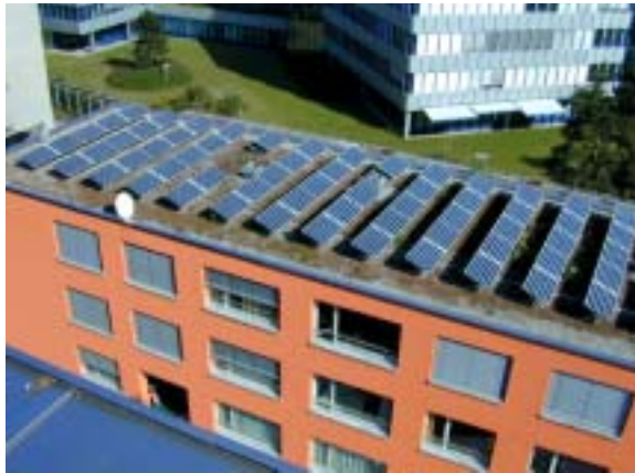
Figur 17: Gründachanlage Solgreen Kraftwerk 1 Zürich (Bildquelle NET)
