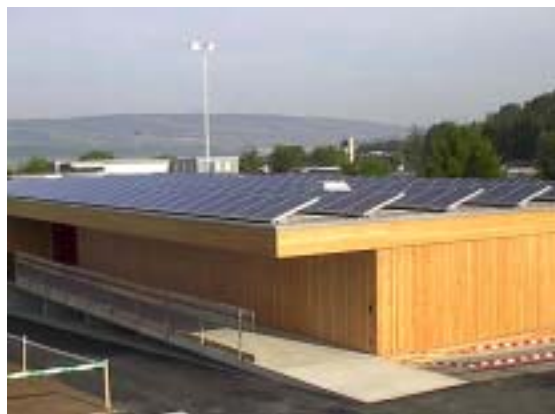
Figur 16: 27 kWp Alustand Hünenberg (Bildquelle Urs Bühler Energy Systems)
