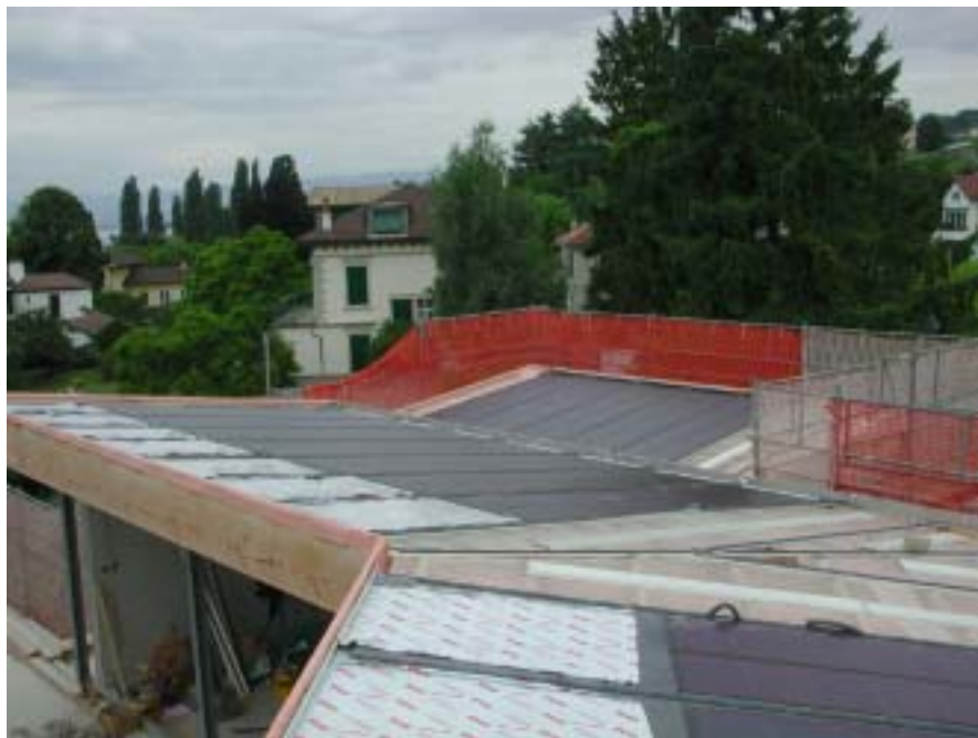
Fig. 6: vue des toitures pendant le chantier
