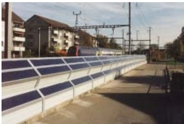
Bild2, Standard-Schallschutzkassetten aus Aluminium mit PV-Laminaten als PV Schallschutzanlage, entlang der SBB Linie Wallisellen – Dübendorf
