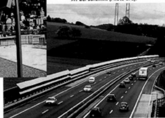
PV-Anlage an der Autobahn A1 bei Safenwil (Photo BFE).
