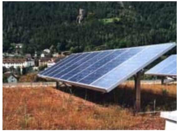
Bild 6: 10 kWp Gründachanlage Solgreen Chur (Bildquelle: NET AG)
