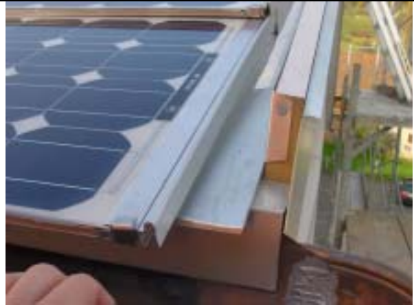
Detail 1 zur Konstruktion der Randabschlüsse
