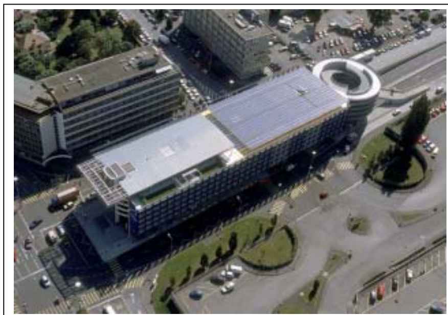
Photo 1 Vue aérienne de l'ensemble de l'installation
