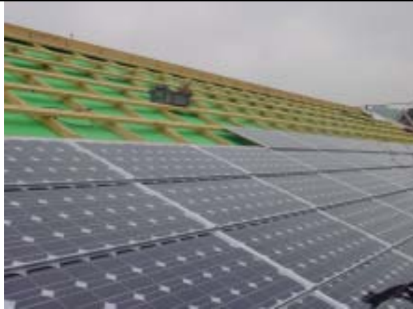
Neue Lattung zur Verbesserung der Hinterlüftung
