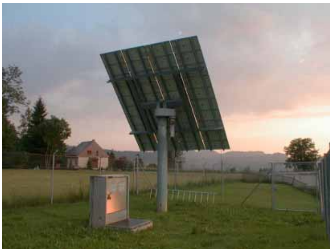
Figure 4: Arbre mobile en position plein OUEST
