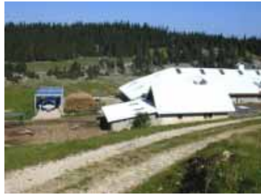
Bild 14: Autonome Anlage Alp Amburnex (Unterstand) (Bildquelle: Services industriels Lausanne)
