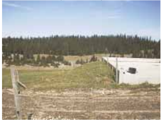
Etat existant - Vue d'ensemble, petit côté, entrée (02.05.2001)
