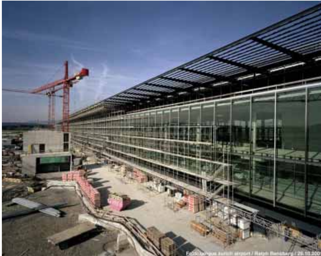
Bild 1: Südfassade Dock Midfield mit der Solarpergola. Im hinteren Teil das auskragende Gerüst für die Montage des Stahlbaues und der Solarlamellen.
