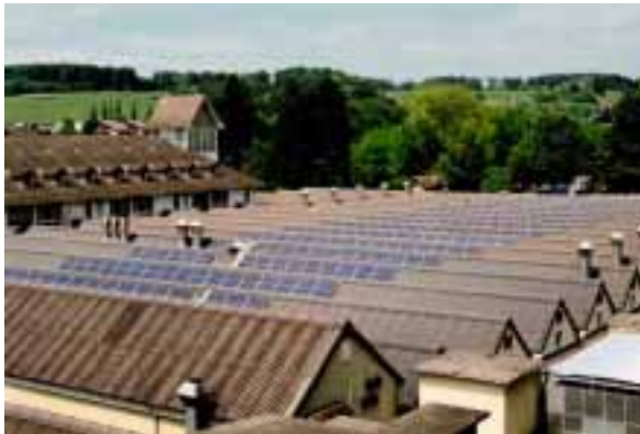
Bild 13: Anlage Felsenau mit LON Überwachung (Bildquelle: NET AG)
