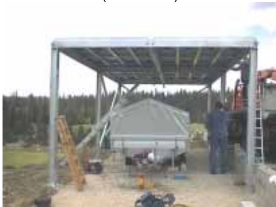
Montage - Vue d'ensemble, petit côté, entrée (13.06.2001)
