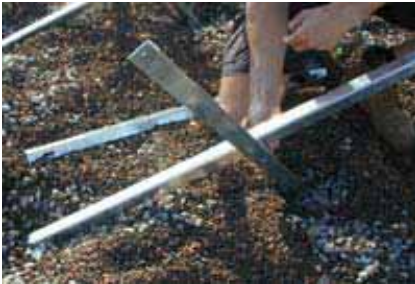
Fig. 7: Nach dem Einstecken Zusammen- schrauben der Stützen
