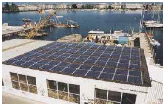
Les Mouettes 11.52 kWp
