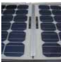
Fig. 12: 12. Aufstecken von U- Profilen an den Seitenrändern verhindert wirkungsvoll ein Durchbiegen
