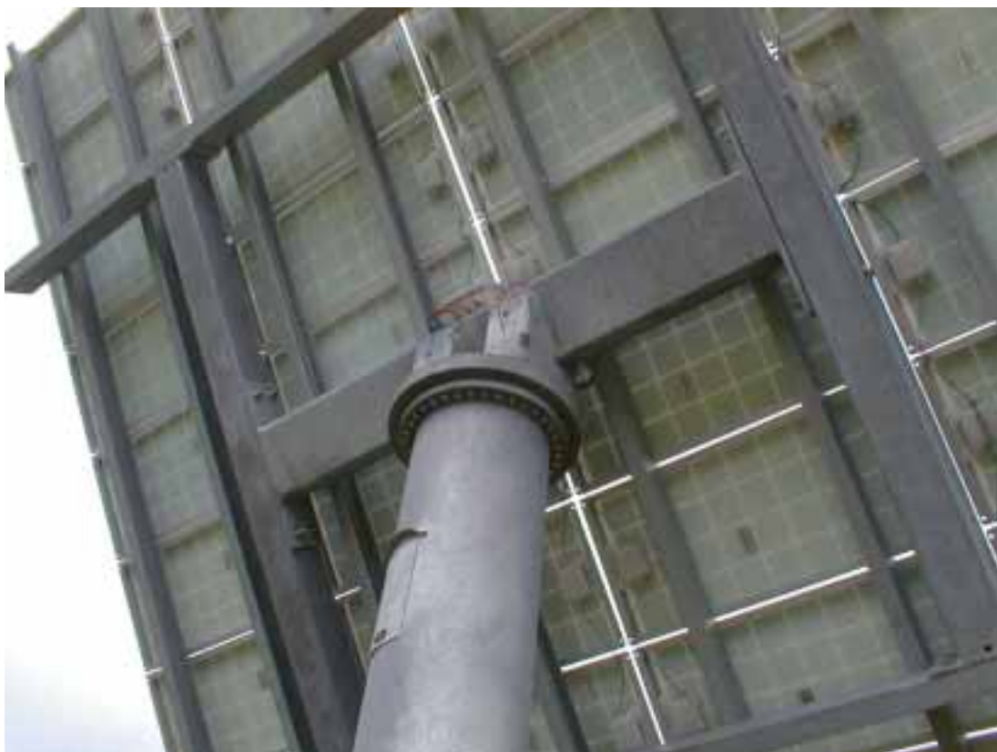
Figure 5: Dispositif d'orientation de l'arbre mobile
