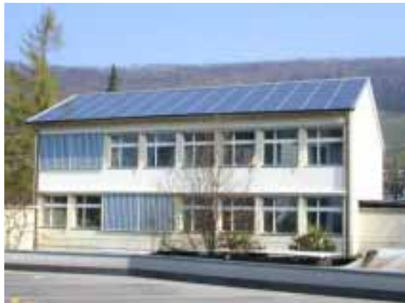
Bild 5: Dachintegration mit SOLRIF Wettingen (Bildquelle: NET AG)
