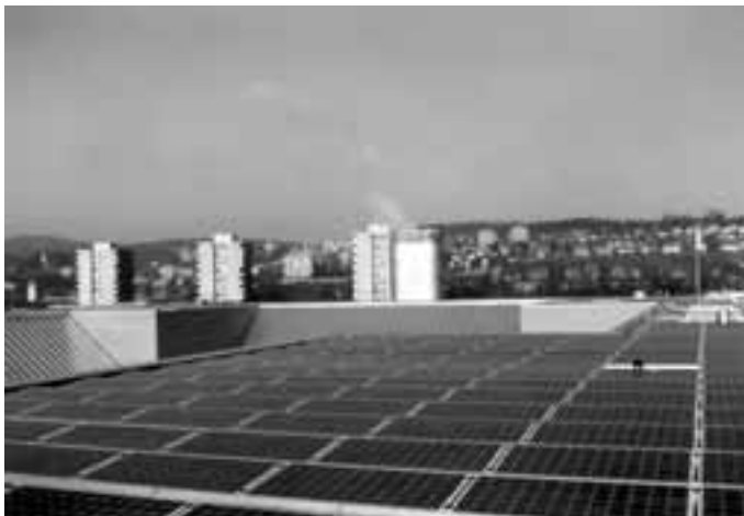
Abb. 1: Photovoltaikanlage auf dem Dach der IBM in Altstetten. Die Neigung der Module beträgt lediglich 5^\circ und die Anlage liegt zwischen Autobahn und Eisenbahnlinie.
