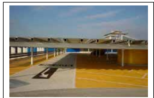
Espace parking sous les modules
