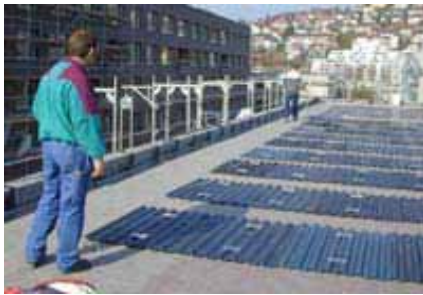
Fig. 5: Auslegen und Ausrichten der Platten
