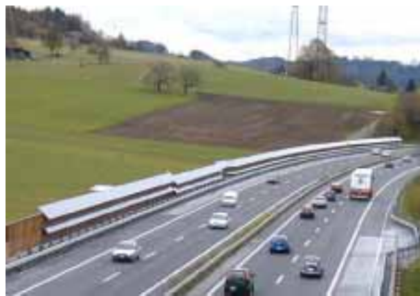
Bild 12: Schallschutzanlage A1 Safenwil (Bildquelle: BFE)
