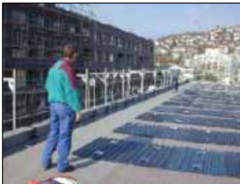
Abb. 7: verlegte Deltatec Platten
