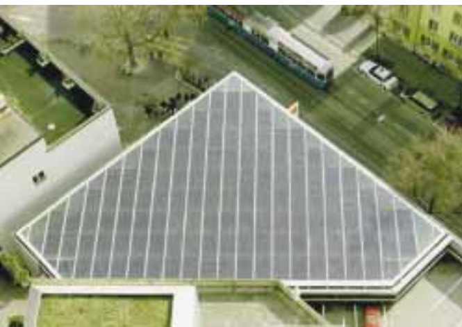
Photovoltaikanlage am Limmatplatz in Zürich (Photos energiebüro).
