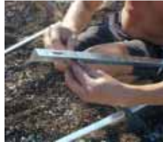
Fig. 8: Einsetzen der Querstrebe, Verschrauben an den Enden der Stützen
