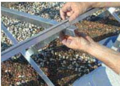
Fig. 9: Anschraben des oberen Solface-Profils
