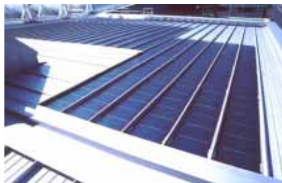
Bild 10: PV Eurodach amorph Flumroc (Bildquelle: NET AG)
