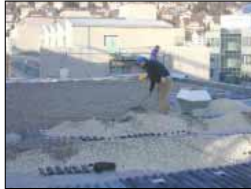
Abb. 4 Die gelegten Deltatec-Platten werden anschliessend mit Bodensubstrat beschwert.
