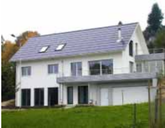
Bild 2: Vollflächige Dachintegration mit SOLRIF (Bildquelle: Enecolo AG)
