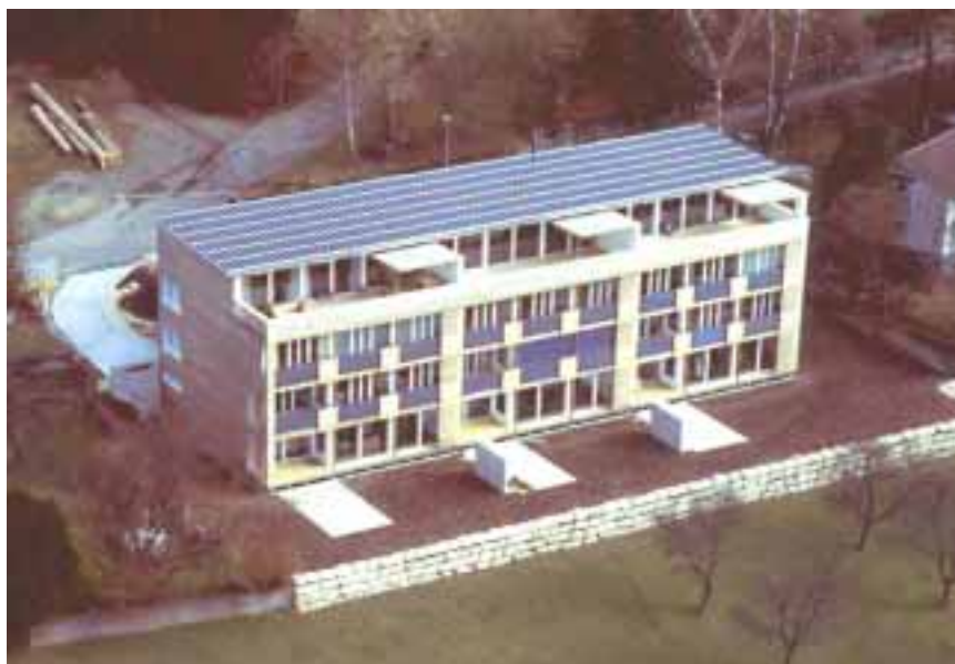
Bild 4: PV Dachintegration mit amorphen Tripelzellen 'Sunny Woods', (Bildquelle: Architekturbüro Beat Kämpfen)
