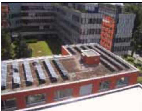
Abb. 1: Solgreen Anlage auf Haus B3
