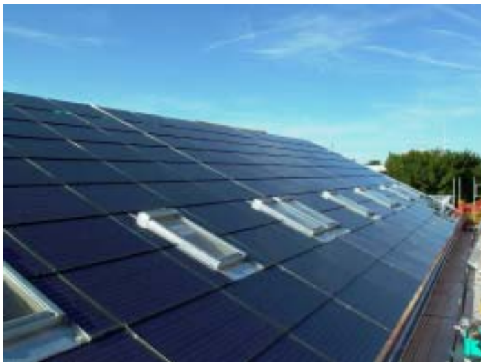
Abb. 4 & Abb. 5 PV-Dach in Herisau, Einbettung von Dachfestern
