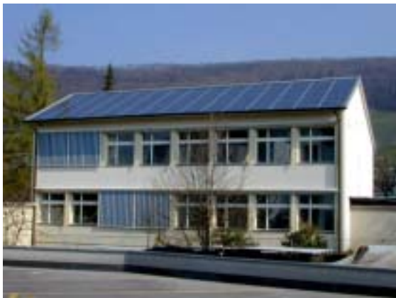
Bild 15: 12,75 kWp Dachintegration Wettingen (Bildquelle: NET AG)
