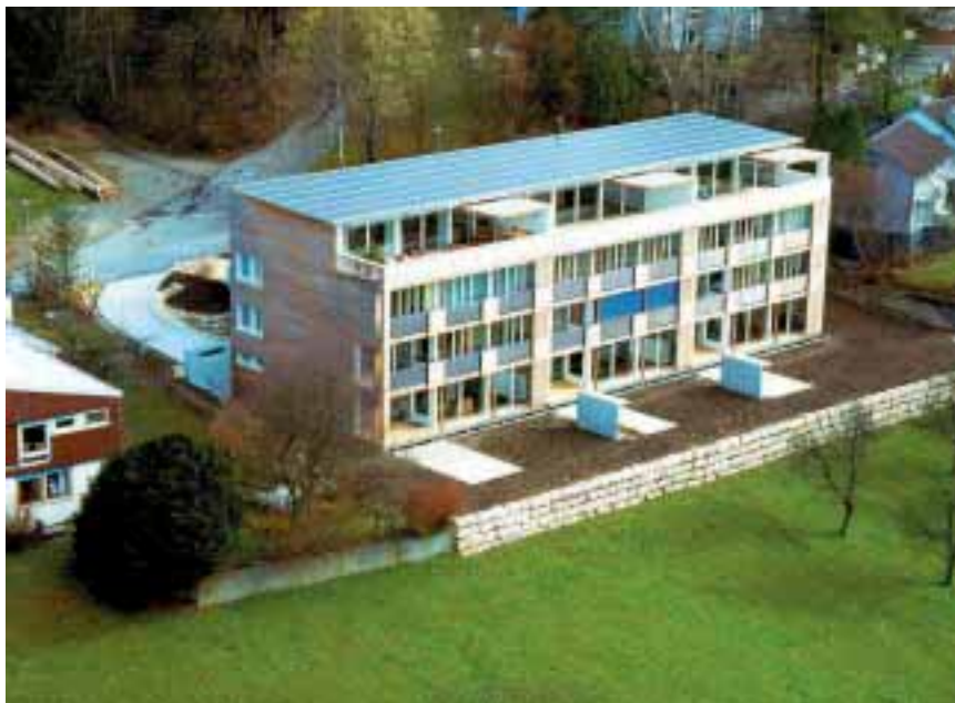
Bild 9: PV Dachintegration mit amorphen Tripelzellen 'Sunny Woods', (Bildquelle: Architekturbüro Beat Kämpfen)
