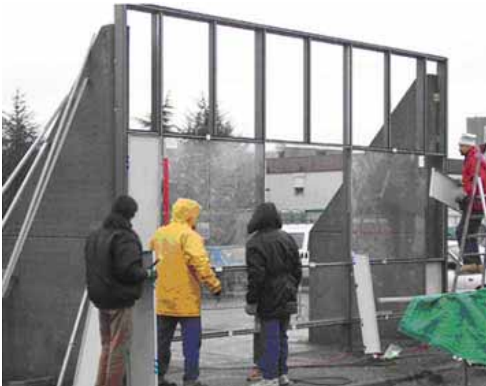
Fig. 8 : montage du stand Kawneer.
