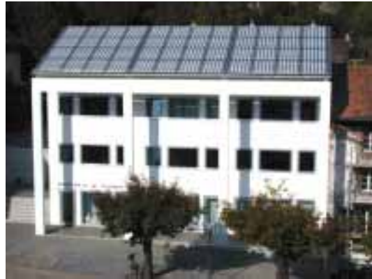
Bild 23: PV Dächer Altstadt Unterseen (Bildquelle: NET AG)
