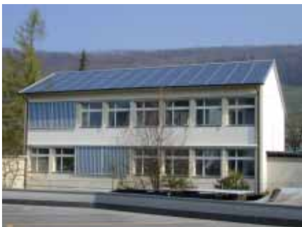
Bild 10: Dachintegration mit SOLRIF Wettingen (Bildquelle: H.-D. Koeppel)
