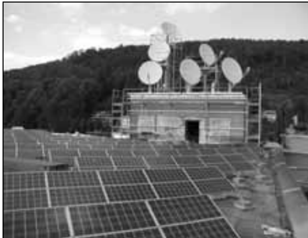
Bild 6: Bei der PV-Anlage EBL Liestal haben sich nach der Dachsanierung einige Änderungen ergeben. Der Solargenerator ist um ein Modul von 18,56 kWp auf 18,51 kWp verkleinert worden. Auf dem Liftgebäude wurden mehrere Parabolantennen installiert, die den Solargenerator am Morgen mehr verschatten. Auf dem Dach wurde ein grosser Träger plaziert (links im Bild noch zu erkennen), dadurch musste ein Teil des Solargenerator weiter in die Nähe des Liftgebäudes verschoben werden. Der genaue Einfluss dieser Änderungen auf den Jahresenergieertrag der Anlage bleibt abzuwarten.
