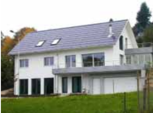
Bild 7: Vollflächige Dachintegration mit SOLRIF (Bildquelle: Enecolo AG)
