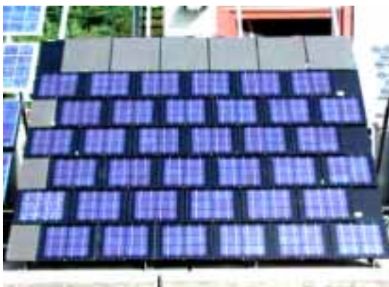
Bild 20: Teststand mit Sunplicity Dachziefern (Bildquelle: TISO)
