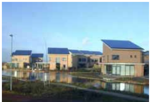
Bild 8: Dachintegrationen mit Alutec / AluVer in Holland (Bildquelle: NET AG)
