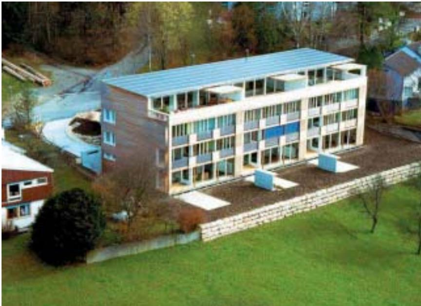
**Bild 9:** PV Dachintegration mit amorphen Tripelzellen 'Sunny Woods',
