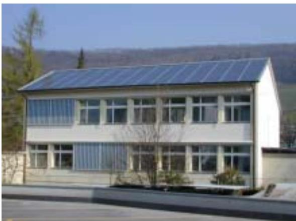
**Bild 10:** Dachintegration mit SOLRIF Wettingen
