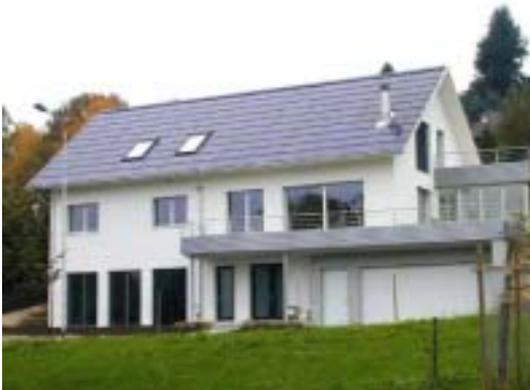
**Bild 7:** Vollflächige Dachintegration mit SOLRIF (Bildquelle: Enecolo AG)
