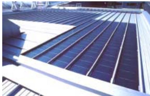
**Bild 15:** PV Eurodach amorph Flumroc
