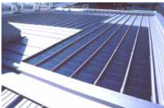
Bild 6: PV Metallfalzdach thermisch isoliert Foto: NET AG
