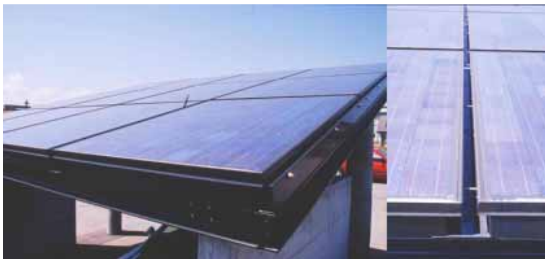
Figure 4. : grâce à un ingénieux système de récupération de l'eau intégré dans la structure, le système Pil-Sim présente un aspect totalement lisse tout en offrant une parfaite étanchéité.
