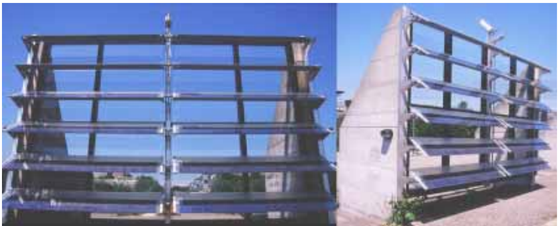
Figure 3. : Les lames du nouveau système de protection solaire Colt ont doublé de longueur ce qui confère au système une ligne plus élégante. Les lames sont actuellement motorisées par un dispositif expérimental entièrement passif (sans aucune consommation d'électricité)
