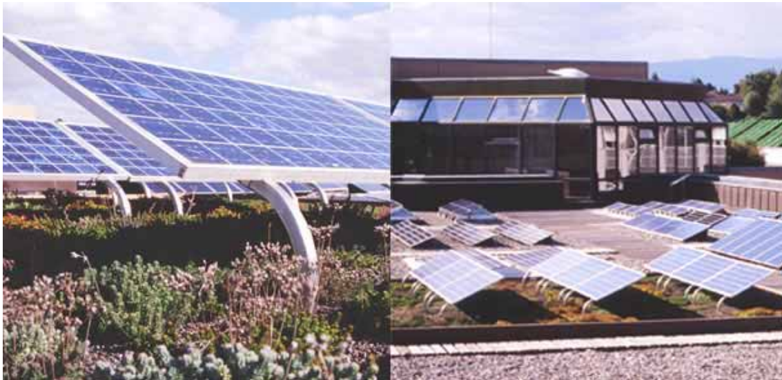
Figure 2. : une mini-toiture végétalisée a été aménagée sur le Demosite pour permettre la présentation du système Solgreen. La végétation est du type extensif et est composée d'un choix de 5 plantes très rustiques et robustes mais créant tout de même un très beau parterre à la floraison.
