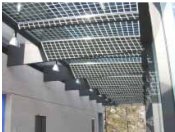
Bild 8: Isolierglasmodule Kantonsschule Stadelhofen, Foto: NET AG
