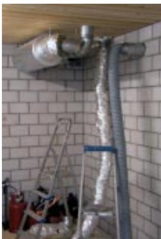
Bild 7: Anschluss der Prüfeinrichtung an das bestehende Kanalnetz
