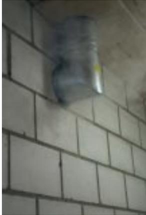
Bild 9: Leckage am Rohrbogen Ofeneintritt
