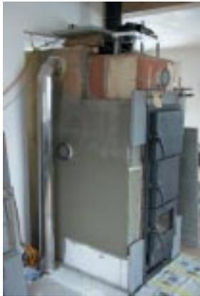
Bild 10: Mörtelschicht an Ofen vorne
