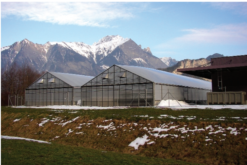
Abb. 4 Solare Klärschlamm-trocknungsanlage Trun
