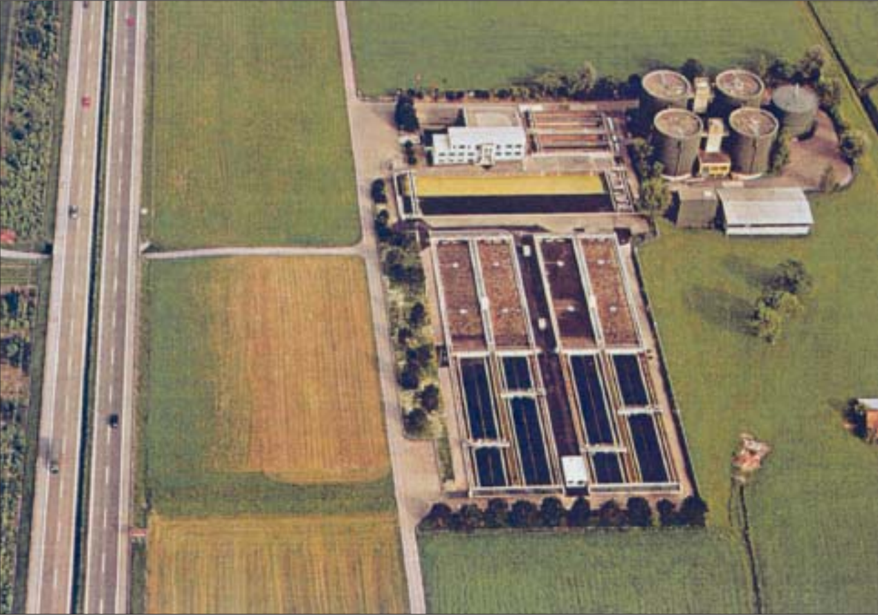
Abwasserreinigungsanlage Glarnerland in Bilten.
