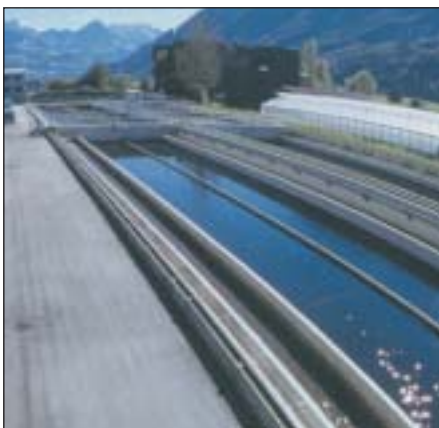
Die Verarbeitung des anfallenden Klärschlammes bildet auch für die Abwasserreinigungsanlage in Bilten eine grosse Herausforderung. Mit der alternativen Trocknung durch Sonnenenergie konnten inzwischen technologische und wirtschaftliche Vorteile nutzbar gemacht werden.
