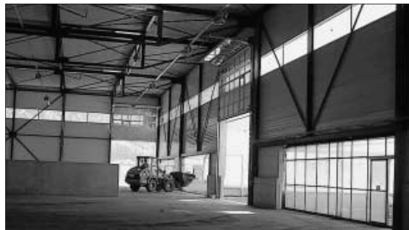
Befüllen der Halle zur «Solaren Trocknung».
