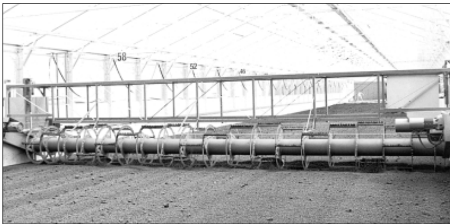
Günstige Energiebilanz: Die solare Trocknungsanlage in Bilten benötigt fast nur Sonnenenergie.
