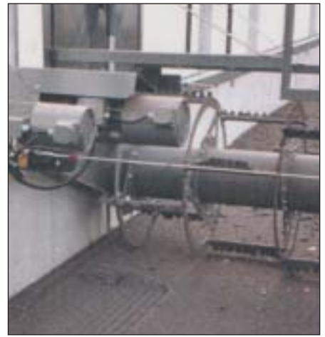
Die Wendemaschine begünstigt den Trocknungsprozess und schiebt die Schicht sukzessive vorwärts. Fotos: O. Fischli.
