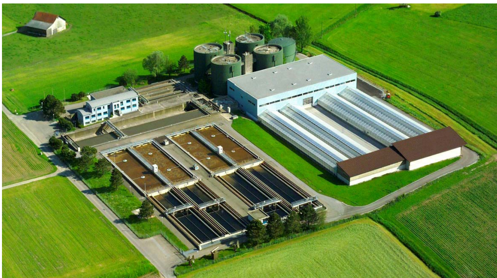
Abbildung 1: ARA in Bilten, rechts die inzwischen vier Trocknungshallen, oben das Zwischenlager und unten die Verladehallen (© Foto-Studio Urs Heer Glarus)
