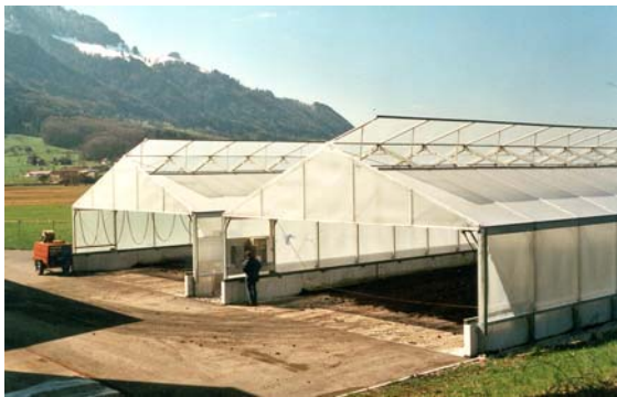
Abbildung 4: Trocknungshallen mit Einfüllöffnung
