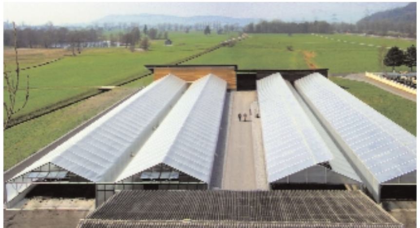
Abb. 3 Solare Klärschlamm-trocknungsanlage Glarnerland
