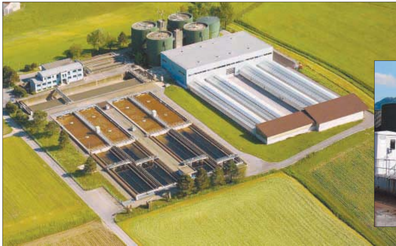
Gesamtansicht ARA Glarnerland.
