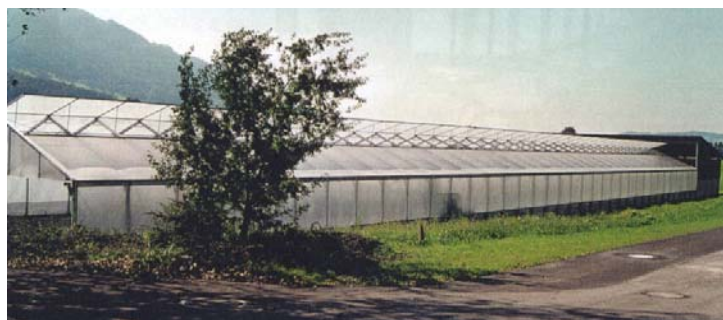
Abbildung 2: Trocknungshalle mit Lüftungsöffnungen, Blickrichtung West
