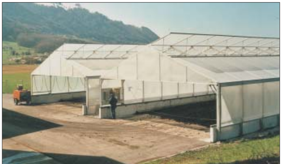
In den Hallen, die Treibhäusern gleichen, wird der entwässerte Faulschlamm auf bis zu 50 % Trockensubstanz vorgetrocknet.
