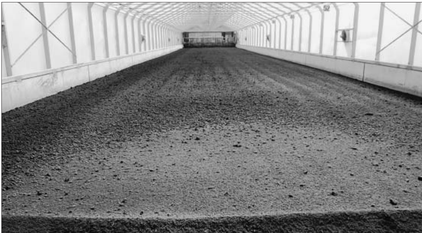
Solare Trocknungsanlage: Die ARA Bilten baut derzeit weiter aus.
