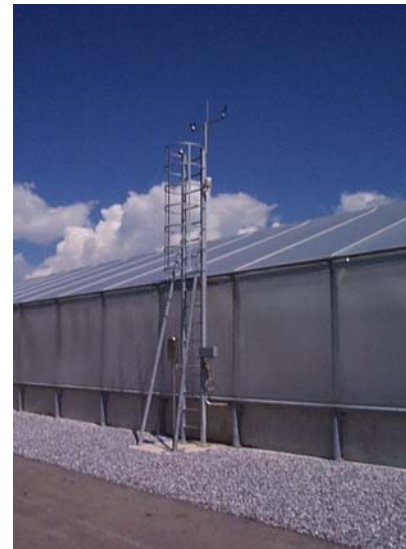
Abbildung 10: Messmast zur Erfassung der klimatischen Daten
