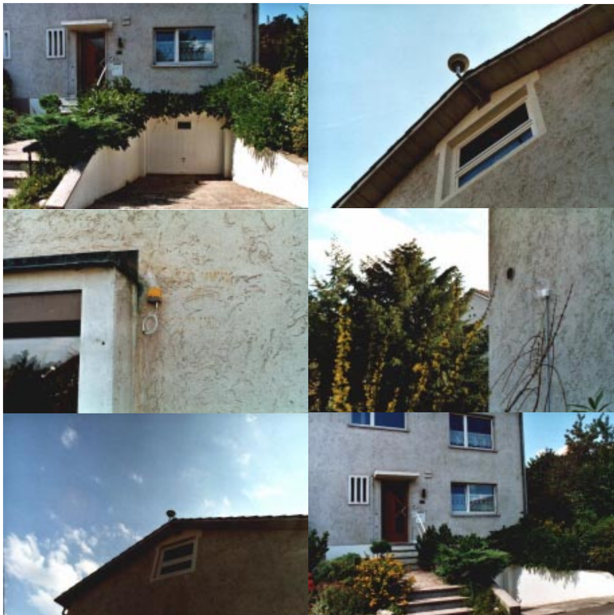
Figur 81: Installation der Sensoren auf Testgebäude in Basel
