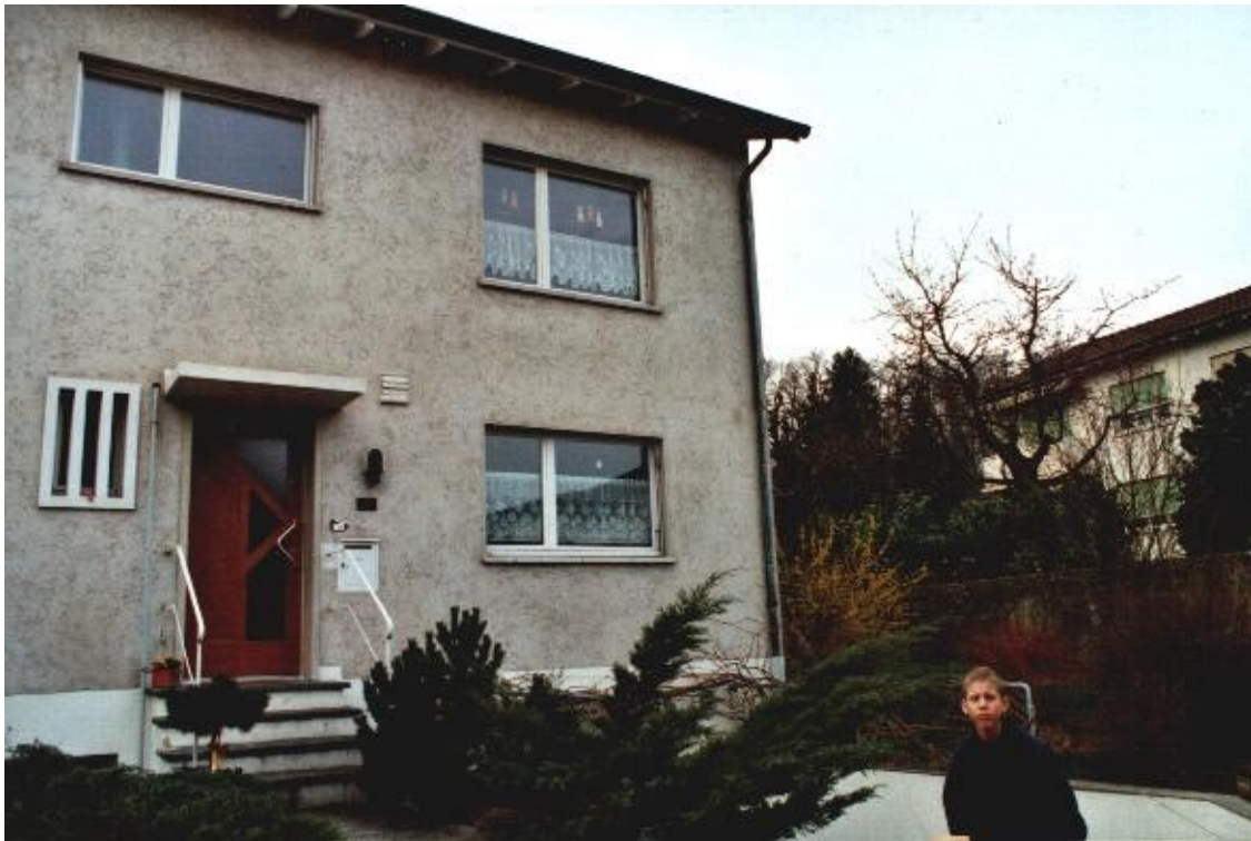
Figur 79: Testgebäude Basel: Ostfassade
