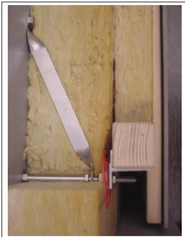
Abb. 7 Detail Anker mit Strebe
