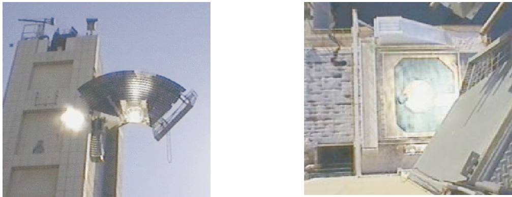
ABBILDUNG 9.7 Bilder der "Beam-down Optics" des Weizmann Instituts, Rehovot, Israel. Linkes Bild: Von Heliostaten beleuchteter Reflektor; rechtes Bild: Blick in den Bodenkonzentrator [SolarPACES].
