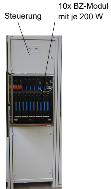
Abbildung 7: Brennstoffzelle 2 kW, Innenaufstellung, Standort 5 (Foto: Benning Schweiz).
