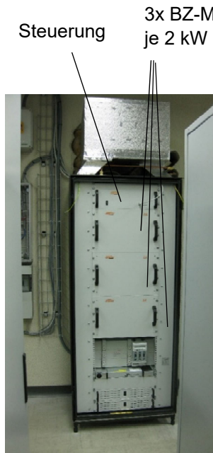
Abbildung 5: Brennstoffzelle 6 kW, Innenaufstellung, Standort 1 -2.
