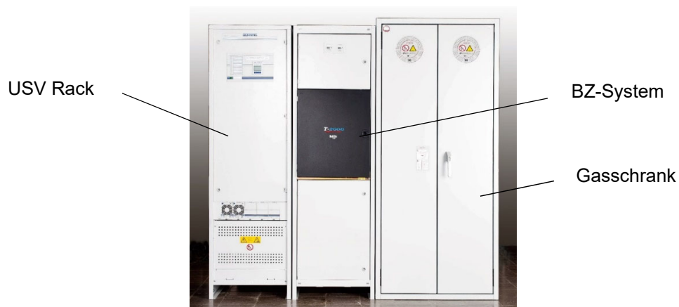
Abbildung 8: Innenraum-Installation mit Standard-USV, Brennstoffzelle und Gasversorgung (Foto Benning Schweiz).
