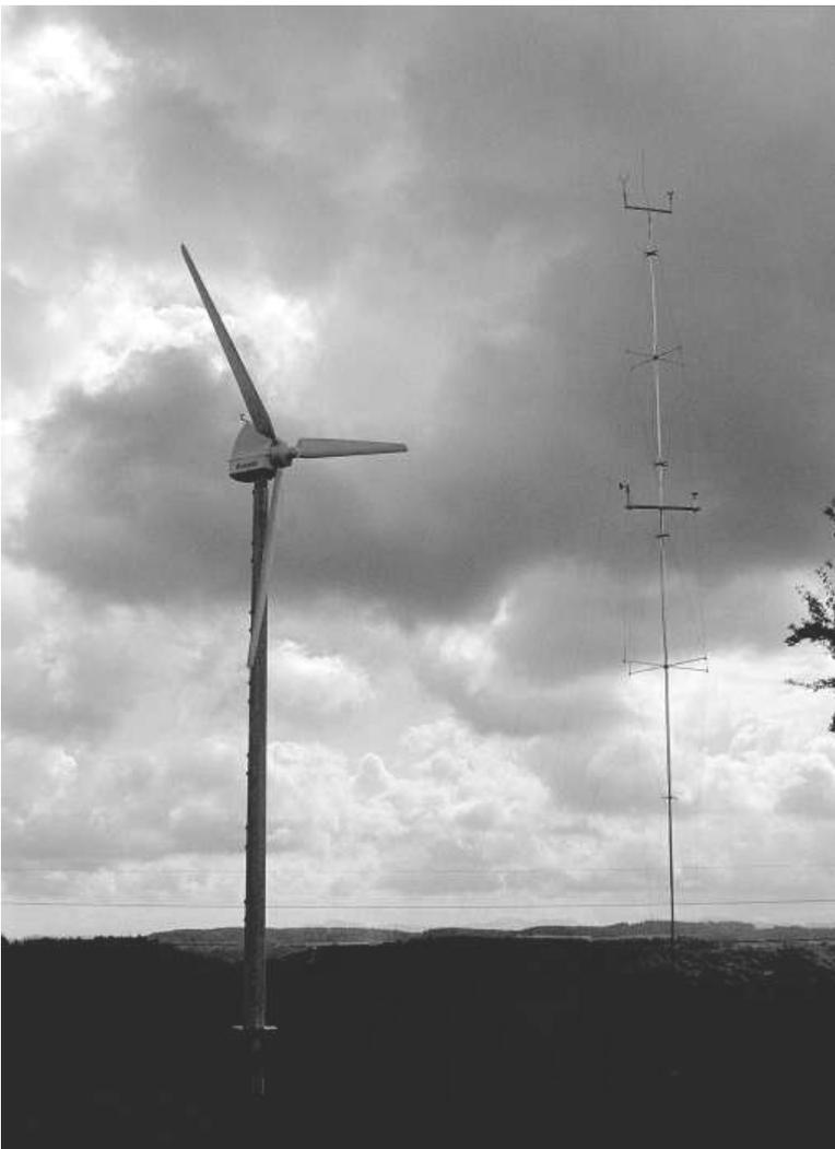
Im Juni 2001 wurde ein Windmessmast westlich der Windkraftanlage aufgestellt und mit Windsensoren bestückt (vergleiche Kapitel 7, Messdatenerfassung).
