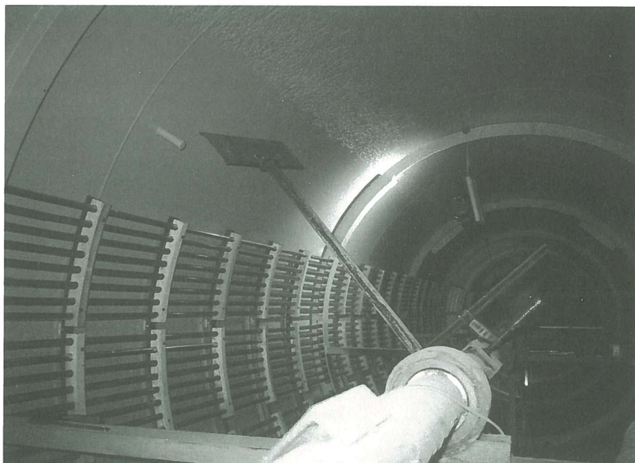
Abb. 7: Innenansicht eines liegenden Fermenters mit Heizregister und Haspelrührwerk.
