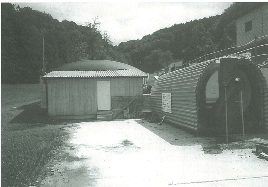
Abb. 1: Co-Vergärungs-Biogasanlage mit integriertem Gasspeicher und Rottetrommel (Grüngutvergärung mit anschliessender Kompostierung).
