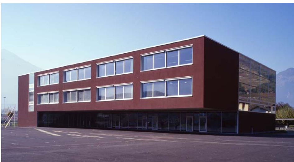
Figure 1: Prise de vue du bâtiment
