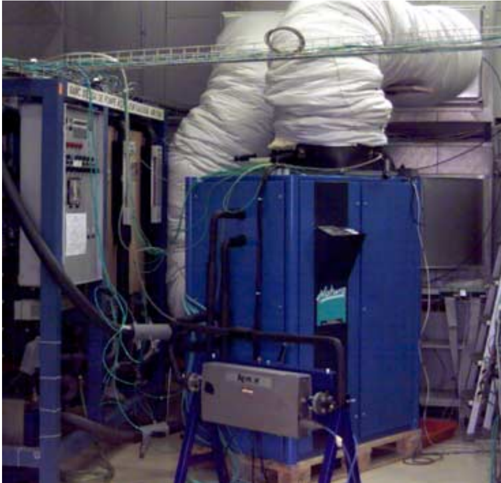
Figure 1: Photo de l'installation dans la halle expérimentale du LENI
