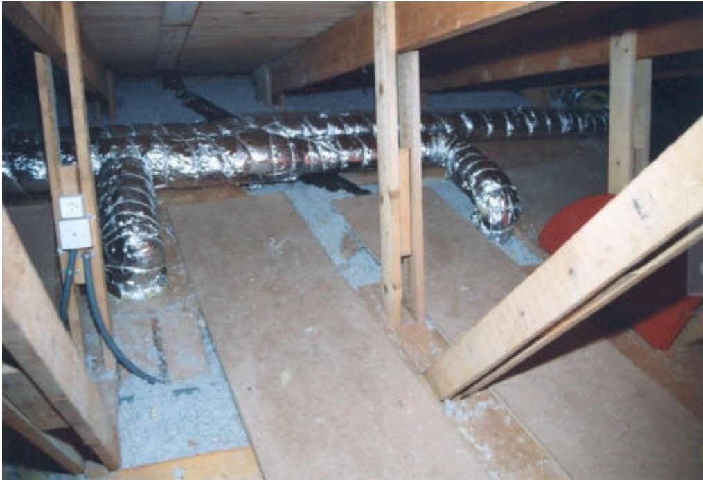
Bild 3: Luftverteilung im Dachraum (Kalt Dach)
