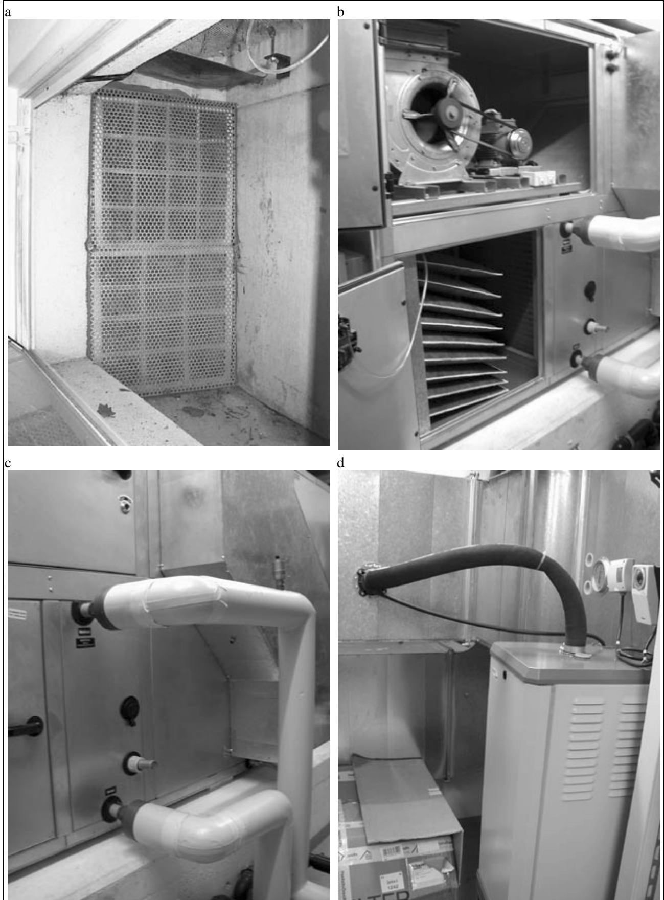
Fig. 4 : a) prise d'air neuf (saut de loup) ; b) récupérateur sur air vicié (filtres sur pulsion et ventilateur sur extraction) et échangeur air/eau ; c) échangeur air/eau et by-pass récupérateur ; d) humidificateur.
