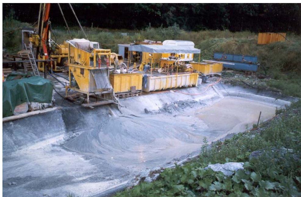
Figure 3 : Vue du chantier du forage géothermique P600. Au premier plan on voit le bac à boue et le tamiseur. La foreuse est visible en haut à gauche de la photo.
