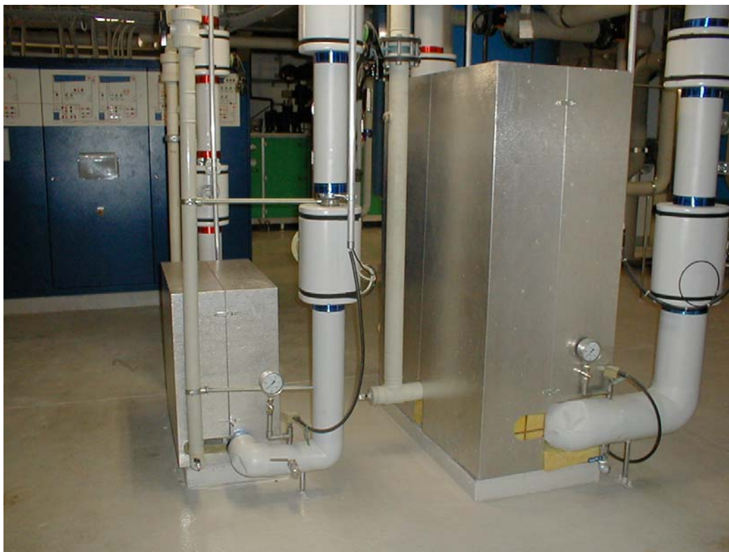
Figure 16 : Echangeurs de chaleur à plaques utilisés par les Bains de Lavey
