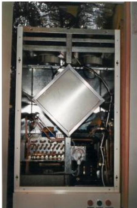
Bild 5-1 Genvex Combi (Lieferant SM-Heag). In der Mitte des Gerätes befindet sich der quadratische Plattenwärmetauscher, oben sieht man (silbrig) die Frischluft-, die Zuluft-, die Abluft- und die Fortluftrohre. Unten links ist der Kondensator und unten rechts der Verdampfer.
