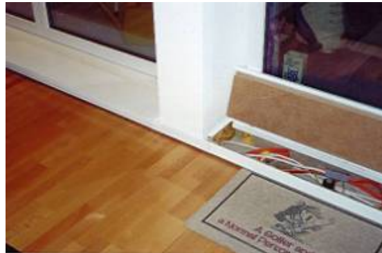
Bild 4-4 Schwellenbereich mit offenem und geschlossenem Schwellendeckel (I&T Bauphysik)
