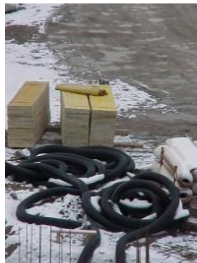
Bild 5-6 Erdregisterrohre während den Verlegungsarbeiten
