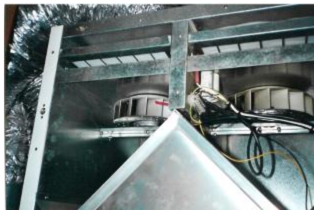
Bild 5-3 Dieses Bild zeigt in der Mitte den Frischluftventilator (rechts) und den Abluftventilator (links), oberhalb der Ventilatoren befinden sich der Frischluftfilter und der Abluftfilter, die die einströmende Luft reinigen und somit die Lüftungsanlage vor Verschmutzung schützen.
