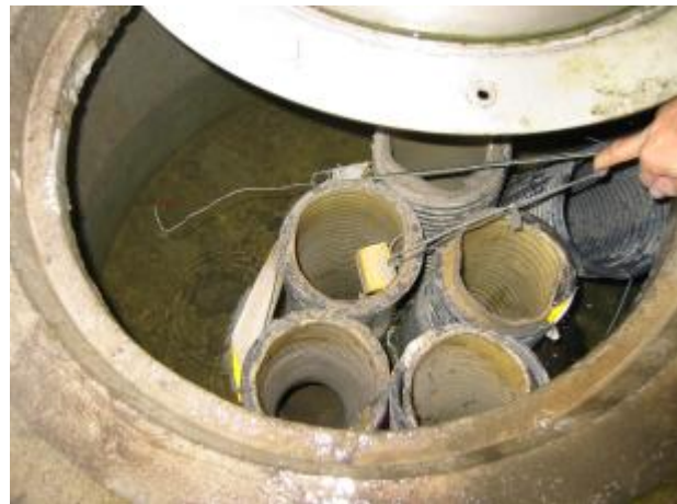
Bild 5-4+Bild 5-5 Ansaugstelle zugedeckt mit Aluminium-Hut und geöffnet mit den nun sichtbaren PE-Rohren des Erdregisters
