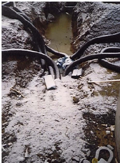
Bild 5-7 Unsorgfältige Verlegung der Erdregisterrohre.
