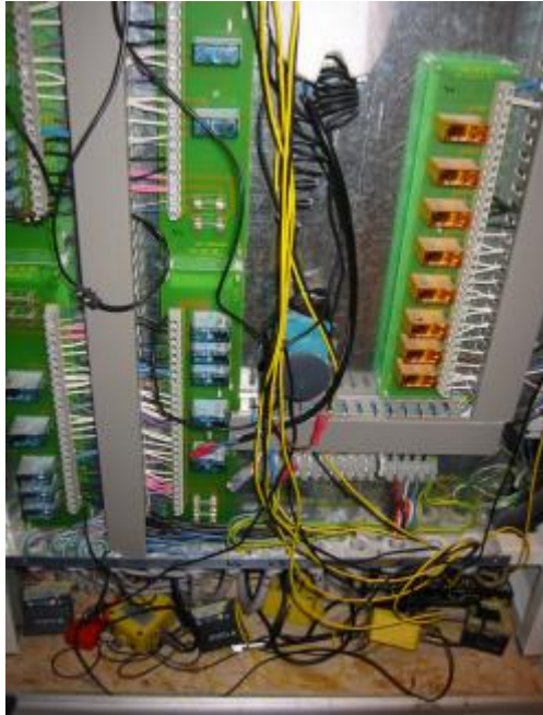
Bild 5-8: Steuerung des Lüftungsgerätes mit Daten-Loggern für die Strommessungen und den Betriebsstundenzählern
