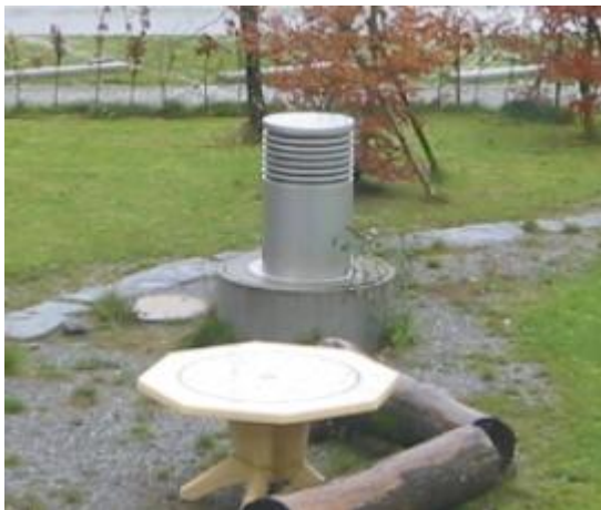
Bild 5-4+Bild 5-5 Ansaugstelle zugedeckt mit Aluminium-Hut und geöffnet mit den nun sichtbaren PE-Rohren des Erdregisters
