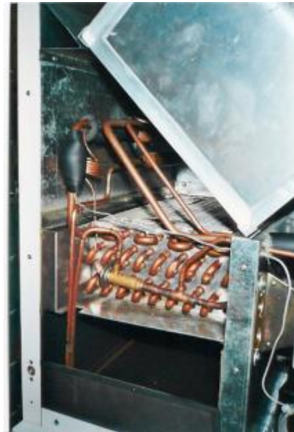
Bild 5-2 Dieses Bild zeigt eine Grossaufnahme des Kondensators. Im Kondensator kondensiert das Frigen aus und überträgt der Frischluft die zurückgewonnene Wärme aus der Abluft.
