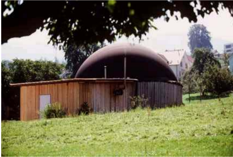
Foto 2: Gesamtansicht der Anlage Schmid, Goldach; vor dem Fermenter der Schutzraum für die Gasverwertung. Der Gasspeicher besteht aus einer die Gülle nach oben abdeckenden, offenen Folienkonstruktion.
