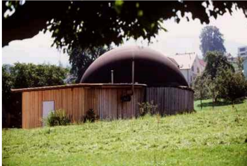
Foto 1: Gesamtansicht der Anlage Schmid, Goldach; vor dem Fermenter der Schutzraum für die Gasverwertung. Der Gasspeicher besteht aus einer die Gülle nach oben abdeckenden, offenen Folienkonstruktion.
