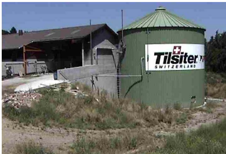
Foto 2: Gesamtansicht der Anlage Wartmann, Bissegg; links vom Fermenter der Lager- und Aufbereitungsbereich. Der Gasspeicher ist unter dem Dach im Fermenter integriert. Das BHKW befindet sich in einem Raum unmittelbar an den Fermenter anschliessend im Untergeschoss des Lagerbereichs.
