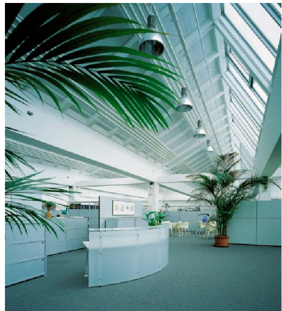
Abb.7: Sicht auf die Deckenstrahlplatten (Zehnder) beim Empfang der Chestonag AG in Seengen. An der Betonsäule in der Raummitte auf der Höhe von 1.6 m befindet sich der Innentemperaturfühler .
