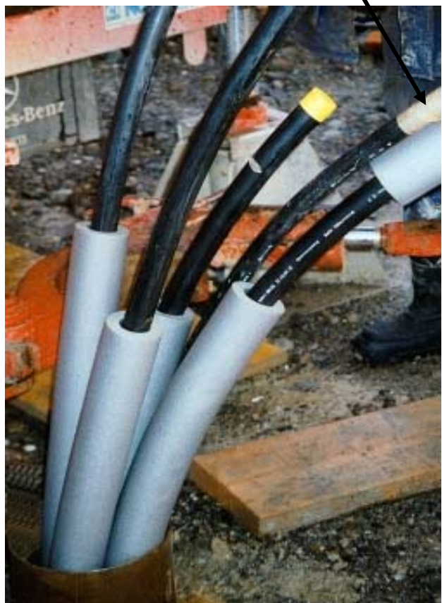
Abb.3: Bohrung mit Erdwärmesonden und Isolation (Tubolit, 2 mm Wandstärke)
