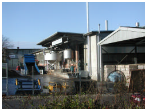
Bild Nr. 1 Grasraffinerie Gesamtansicht
