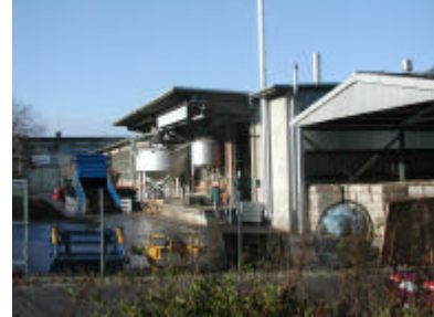
Bild Nr. 1 Grasraffinerie Gesamtansicht
