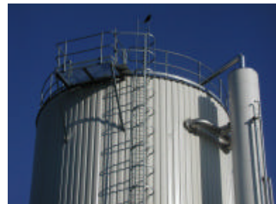
Bild Nr. 3 Bioreaktor mit 600 m3 Inhalt
