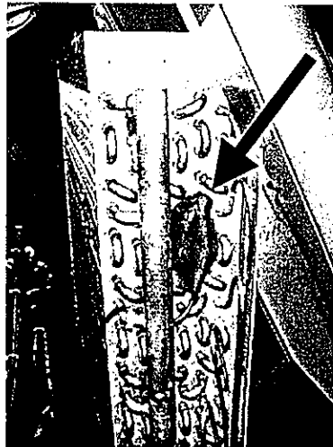
Abb. 16 Verdampferstirnseite mit dem, an einem Kupferrohrbogen angebrachten, Verdampfungstemperaturfühler
