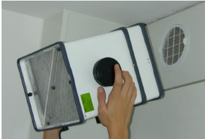
Abbildung 3.1 Für jeden Luftdurchlass wurde die aus- bzw. eintretende Luftmenge bestimmt
