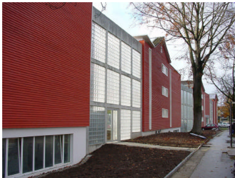
Abbildung 1.2 Schallschutzwand von Aussen (strassenseitig ; (Foto: Visini)
